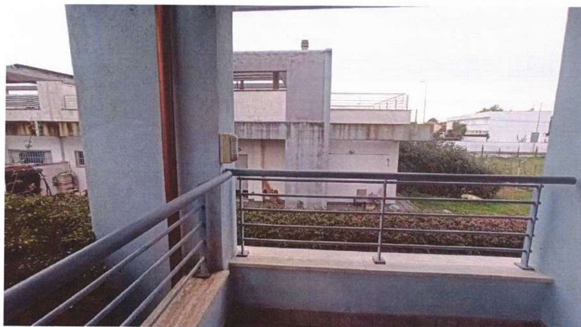
Foto 50 – BALCONE, VISTA LATERALE
