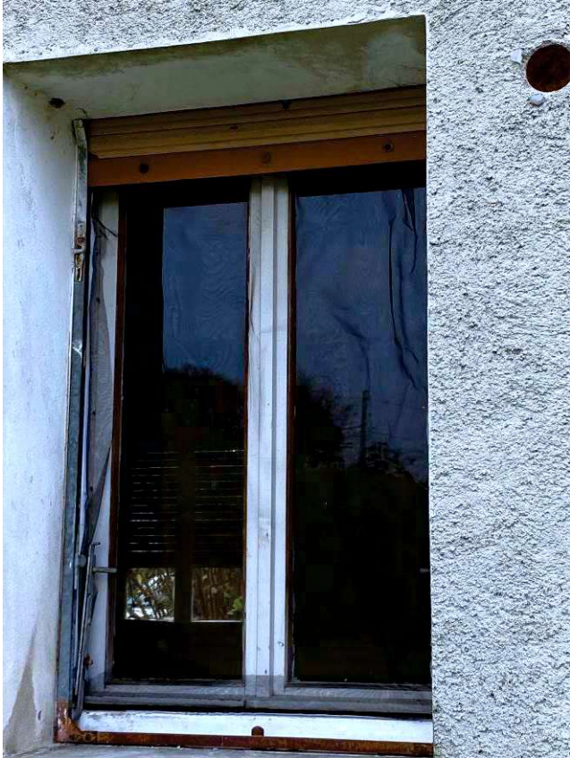
vista degrado vetusti serramenti ed avvolgibili
