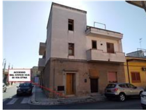
2 - VISTA ESTERNA DELL'UNITÀ IMMOBILIARE CON ACCESSO DA VIA ETNA N.33/A
