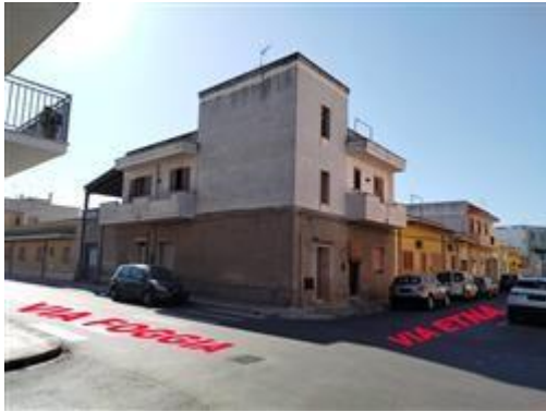
1 - VISTA DELL'EDIFICIO DA VIA FOGGIA
