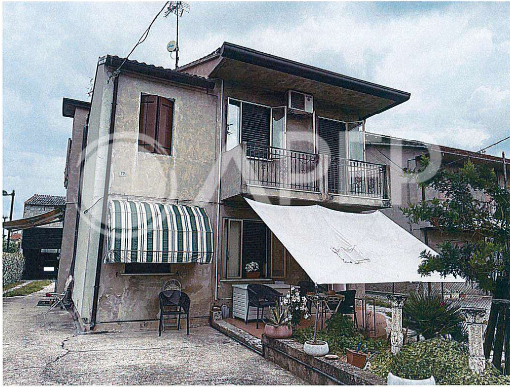
FABBRICATO OGGETTO DI E.I. VISTA SUD-EST
