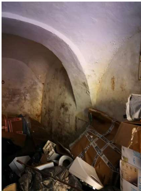
Fotogramma 14 – Napoli – Magazzino Via Riviera di Chiaia n. 270 – Viste interne
