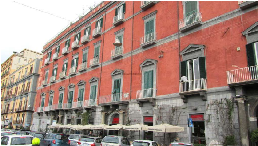
Fotogramma 11 – Comune di Napoli – Facciata stabile condominiale alla Via Riviera di Chiaia n. 270
