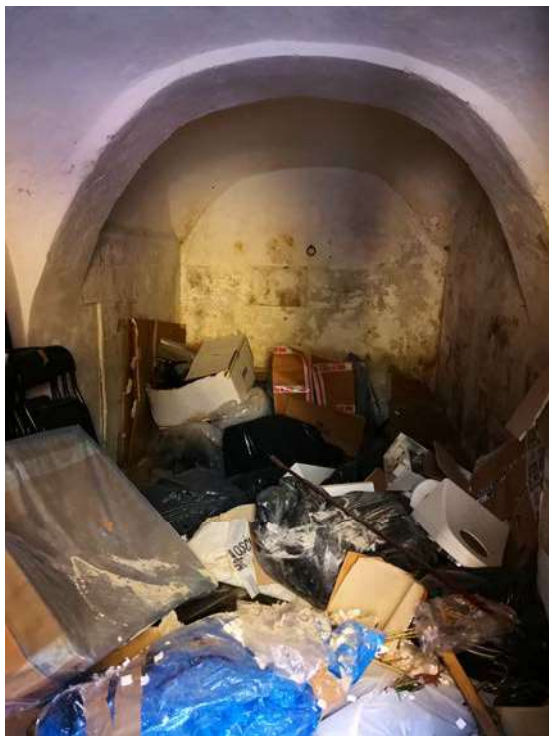
Fotogramma 13 – Napoli – Magazzino Via Riviera di Chiaia n. 270 – Viste interne
