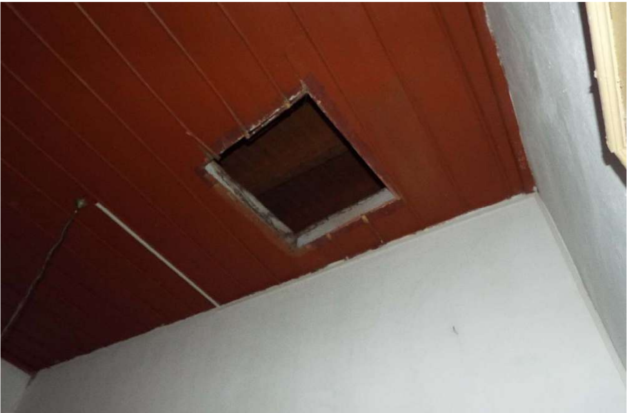
Controsoffitto del disimpegno con botola
