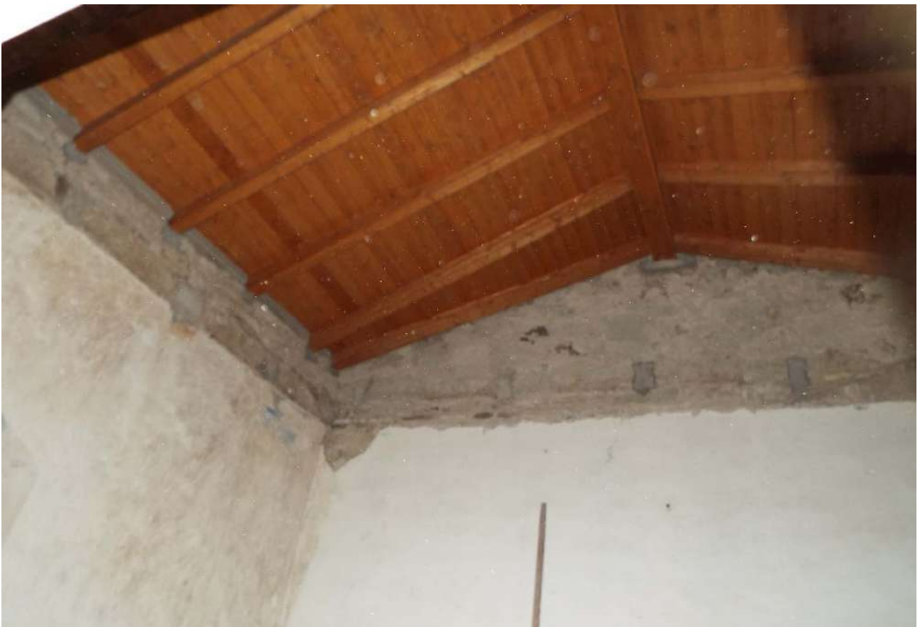
Copertura camera da letto
