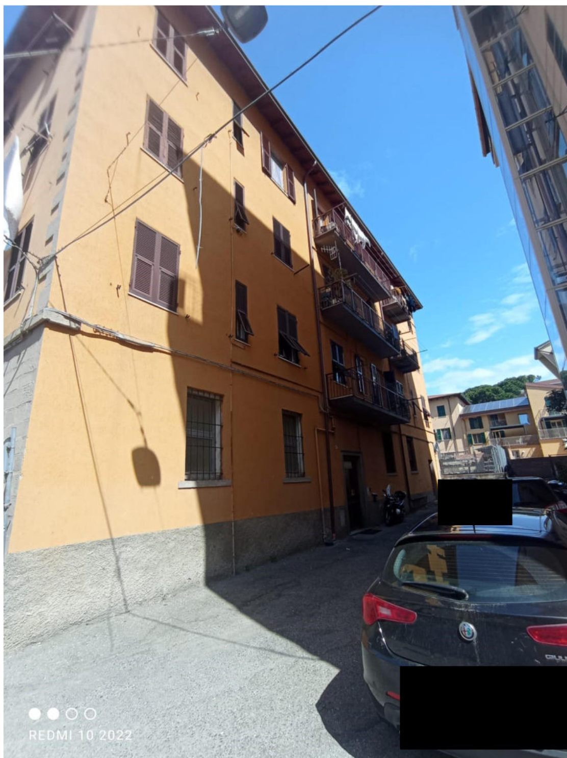
Figura 1 l'edificio condominiale via Alberto Picco 47
