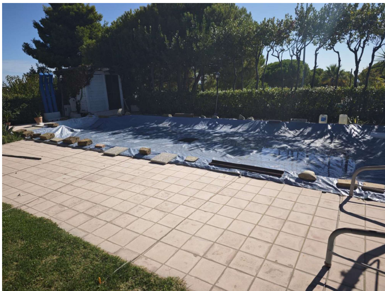
FOTO N.3 ABUSO sub c) piscina
