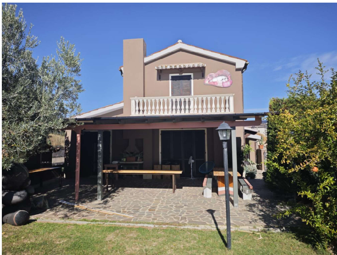
FOTO N.2 ABUSO sub b) portico
