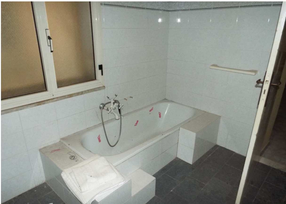
Dettaglio vasca da bagno
