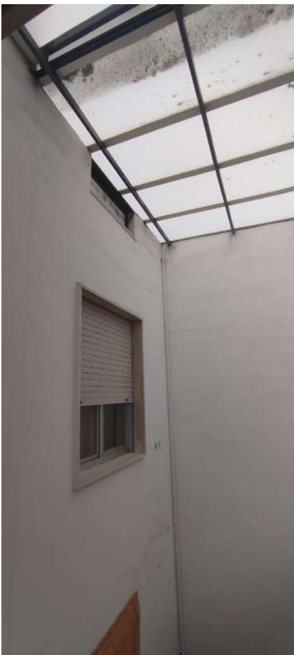
Foto 25. Pozzo luce coperto.
