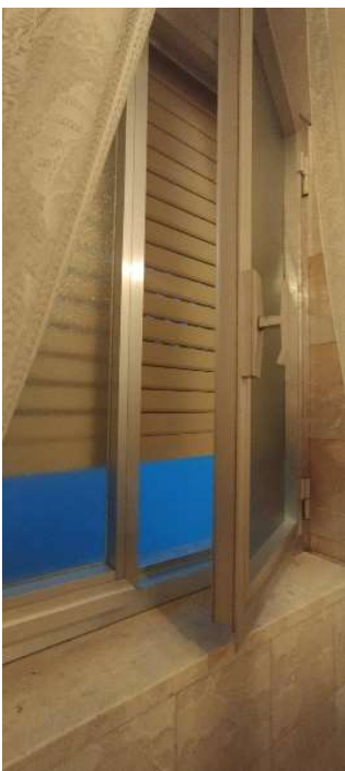
Foto 35. Vano bagno. Infisso.
