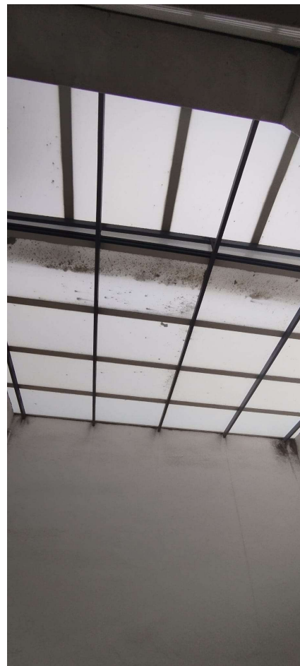
Foto 26. Pozzo luce coperto.
