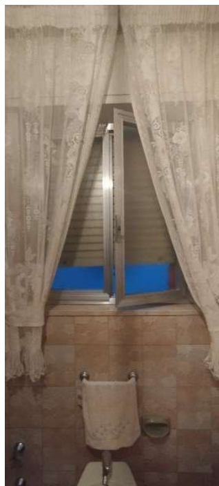
Foto 36. Vano bagno. Infisso.
