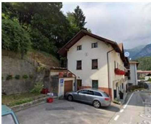
vista da sud-est entrata edificio e garage
