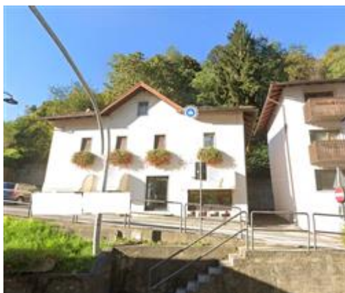
VISTA DA STRADA STATALE (EST VALLE)
