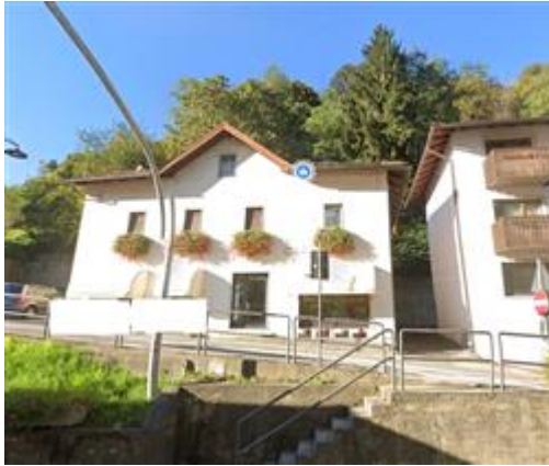
VISTA DA EST STRADA
