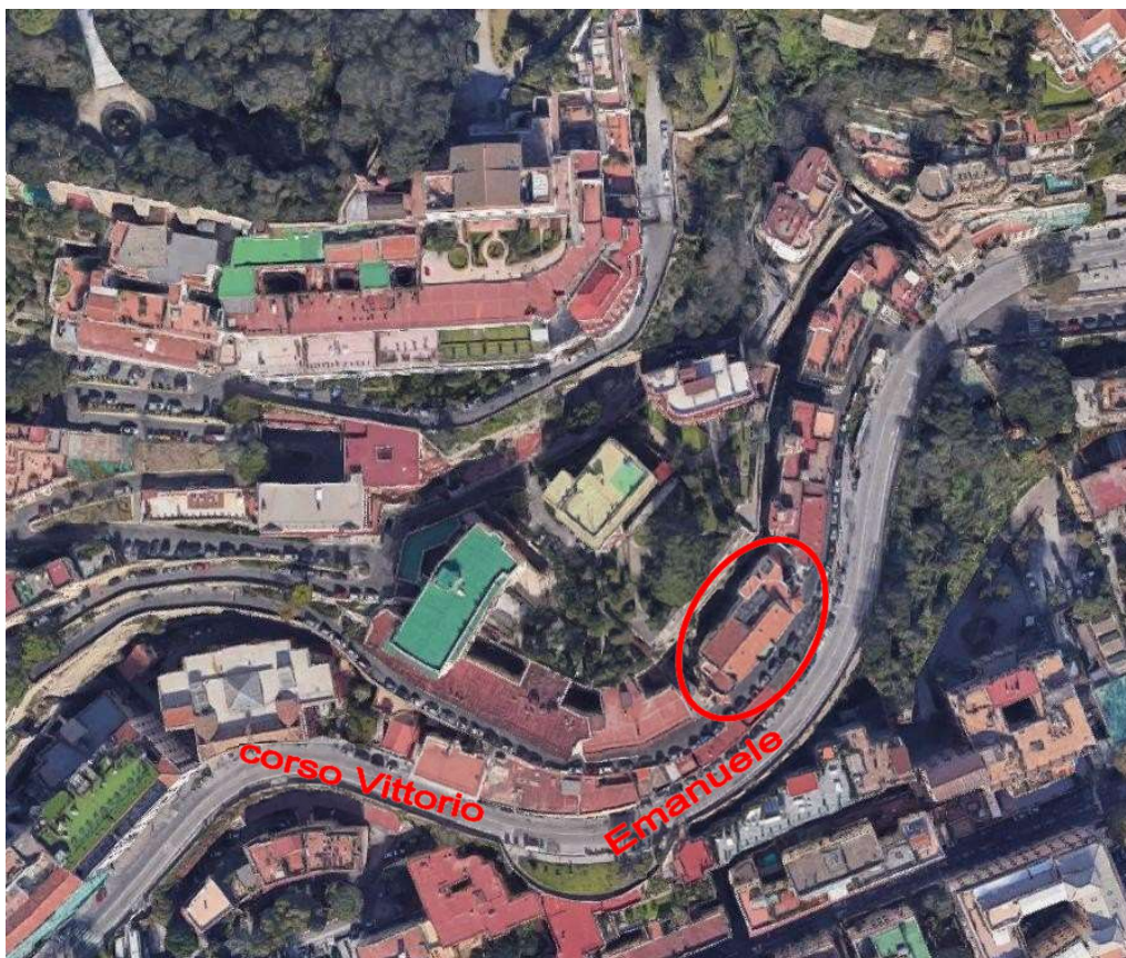
inquadramento territoriale - fabbricato del cespite pignorato
