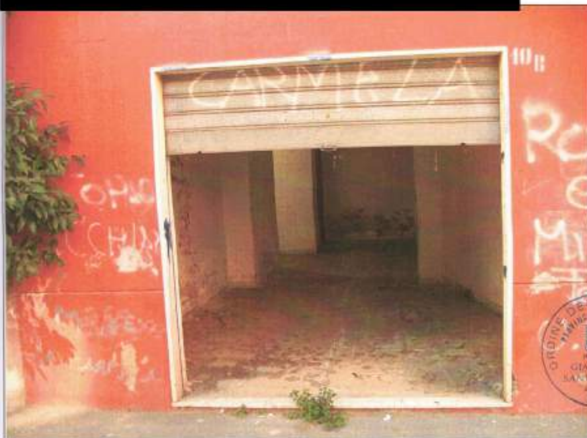
↑ Foto5 Immobile A1, Locale Piano Terra In Via Risorgimento n°10B (NCEU Nocera Superiore Fg.7, Part.810, Sub.2). Vista dall'esterno.
