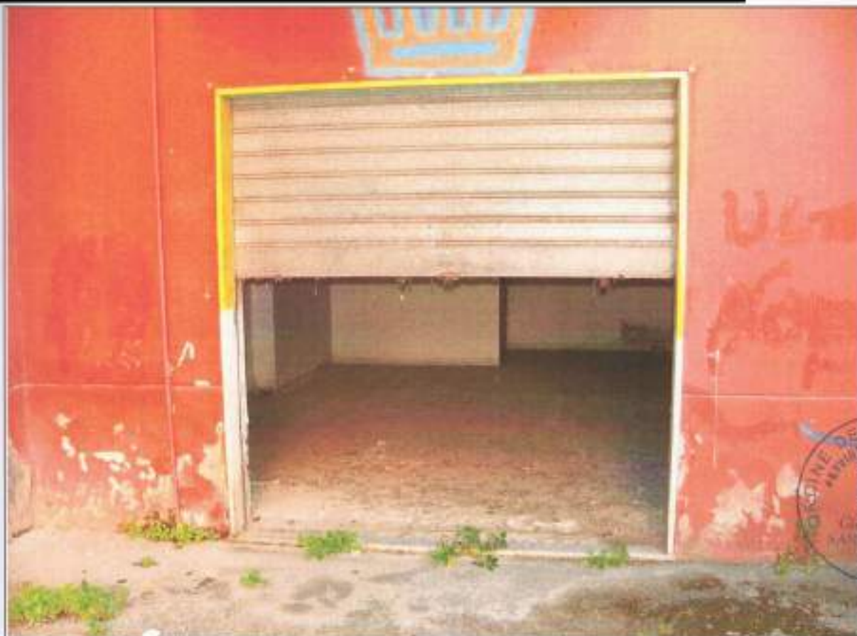
↑ Foto9 Immobile A3, Locale al Piano Terra su Via Risorgimento nel fabbricato con portone al n°10C (NCEU Nocera Superiore Fg.7, Part.810, Sub.4). Vista esterna.
