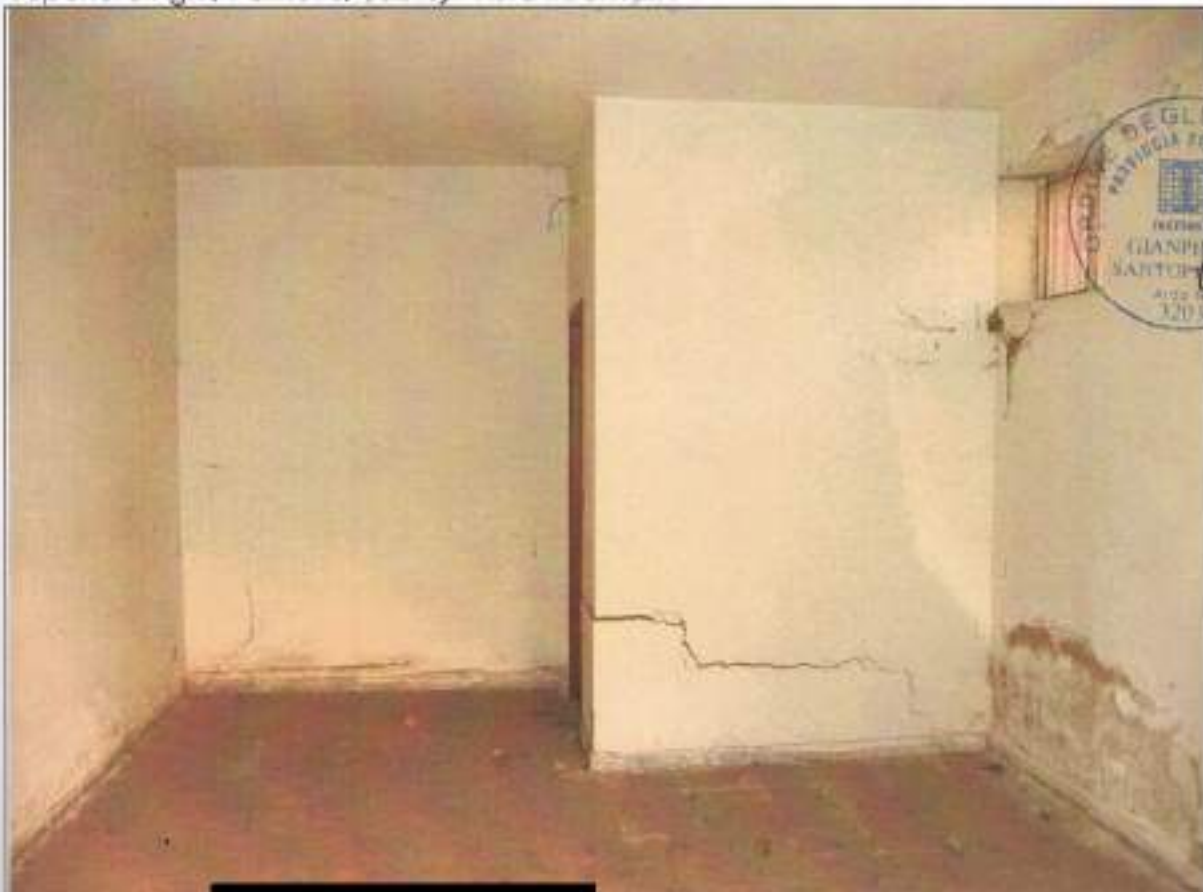
↓ Foto8 Immobile A2, Locale Piano Terra in Via Risorgimento n°10A (NCEU Nocera Superiore Fg.7, Part.810, Sub.3), Vista interna.
