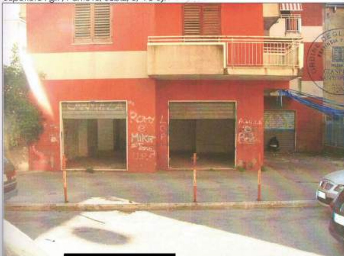
↓Foto4 Vista dei locali piano terra in Via Risorgimento n°10C (NCEU Nocera Superiore Fg.7, Part.810, Sub.2, 3, 4 e 5).
