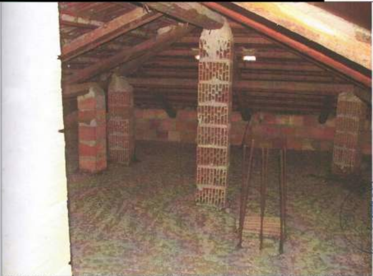
↑ Foto21 Immobile A8, Vano Sottotetto in Via Risorgimento n°10C (NCEU Nocera Superiore Fg.7, Part.810, Sub.9).
