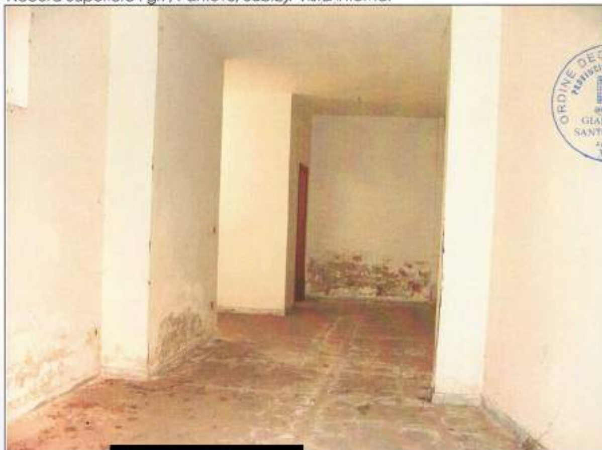
↓ Foto6 Immobile A1, Locale Piano Terra In Via Risorgimento n°10B (NCEU Nocera Superiore Fg.7, Part.810, Sub.2). Vista interna.
