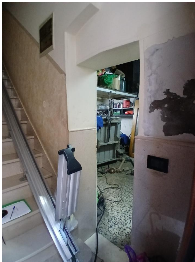
ACCESSO AL BOX DAL VANO SCALA
