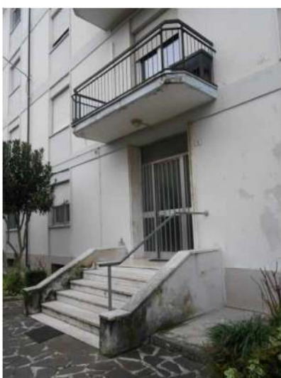
Accesso all'androne e al vano scale dall'area comune
