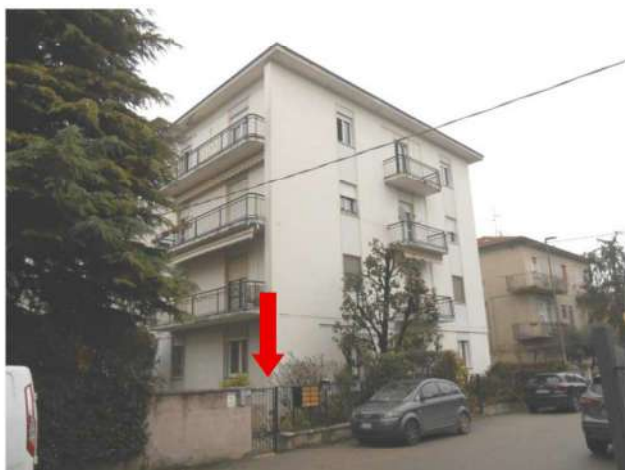
Ingresso pedonale da Via Grigolin
