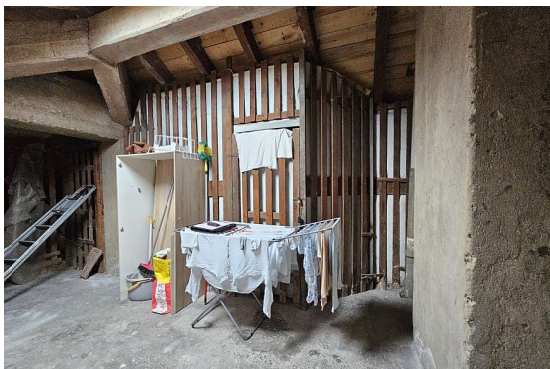
Vano comune nel sottotetto
