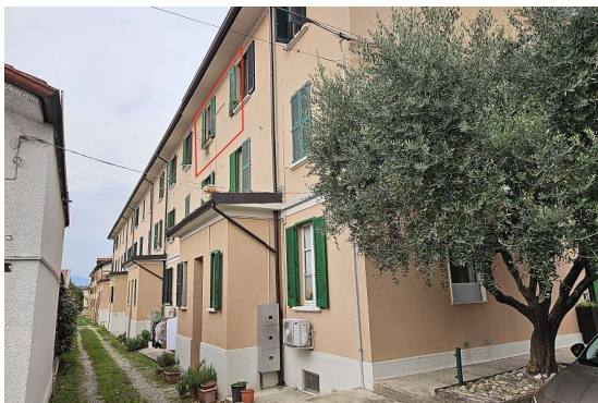
Vista posteriore dell'immobile
