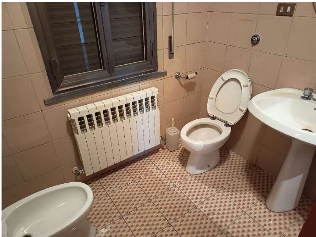
FOTO N. 23 – bagno abitazione piano secondo
