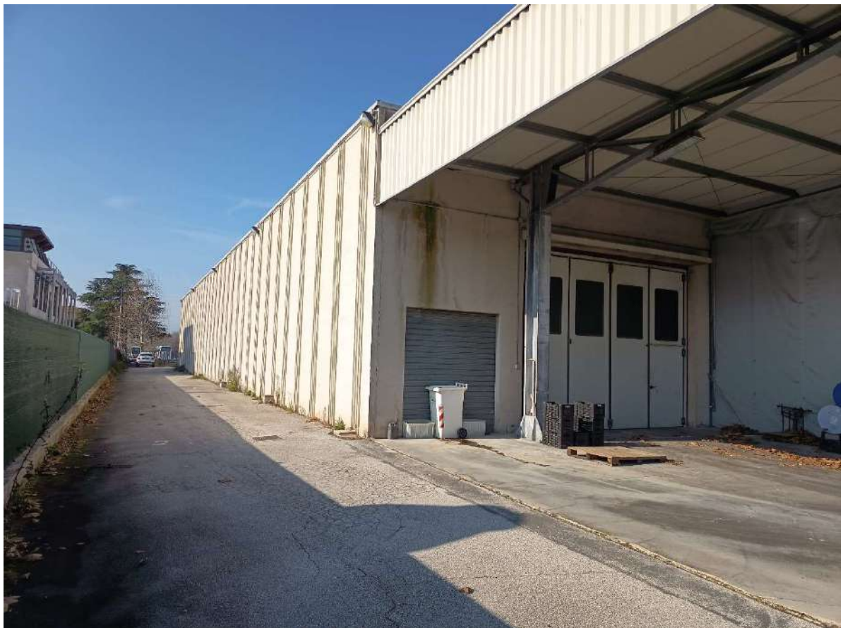
FOTO N. 6 – prospetto laterale sud
