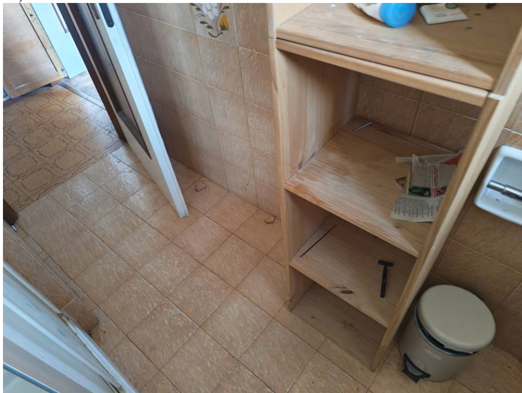
FOTO 61 – doccia-WC dell'alloggio (unità condominiale "8", subalterno catastale 13)
