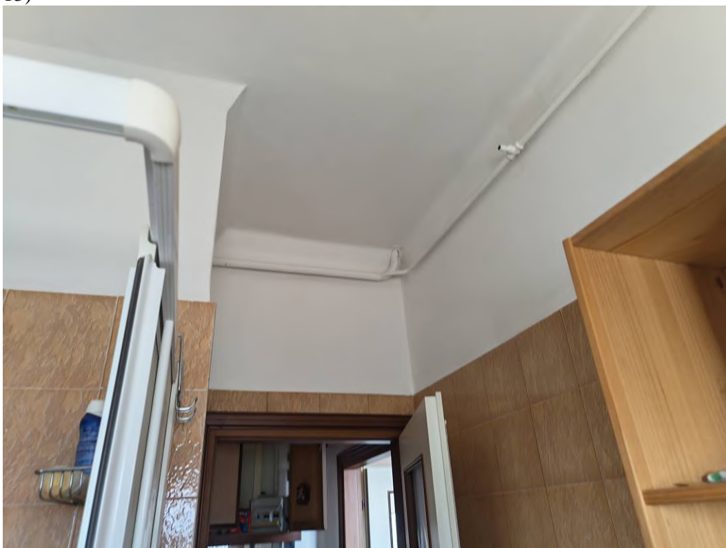
FOTO 60 – doccia-WC dell'alloggio (unità condominiale "8", subalterno catastale 13)
