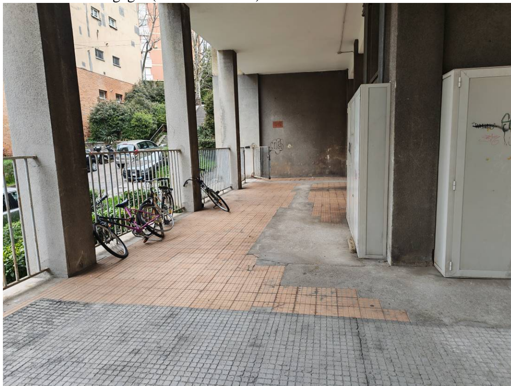
FOTO 13 – Porticato del condominio di Viale Campi Elisi n. 20 (p.c.n. 6133/17 del C.C. di Trieste); sulla destra l'armadiatura dei contatori elettrici e, visibile, un'ulteriore armadiatura dei contatori del gas metano; sulla sinistra si affaccia Via Giambattista Morgagni (cfr. FOTO 1 e 2)
