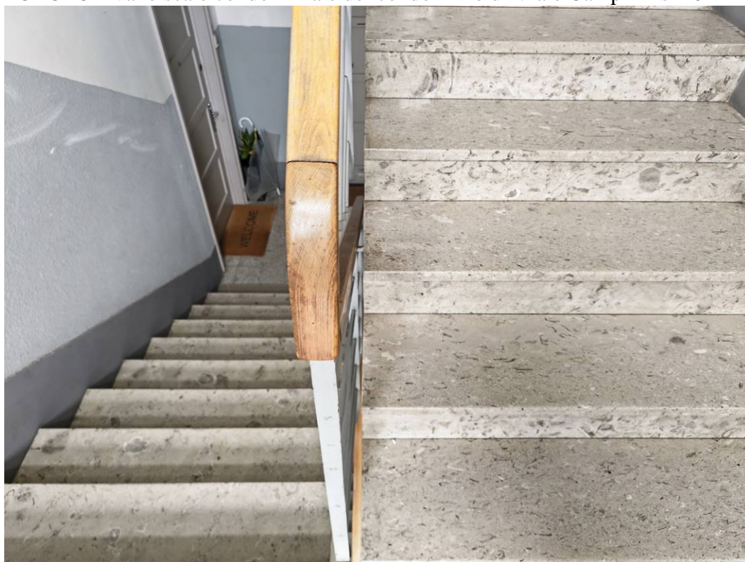
FOTO 25 – vano scale condominiale del condominio di Viale Campi Elisi 20
