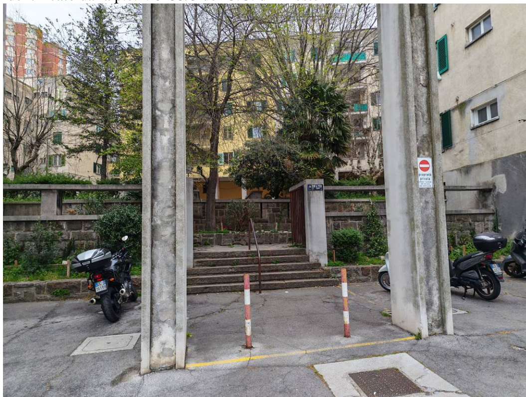
FOTO 5 – Immagine ripresa da Viale Campi Elisi: ingresso al complesso immobiliare di cui fa parte il condominio sito al civico n. 20; accesso al cortile identificato dalla p.c.n. 6133/3 del C.C. di Trieste
