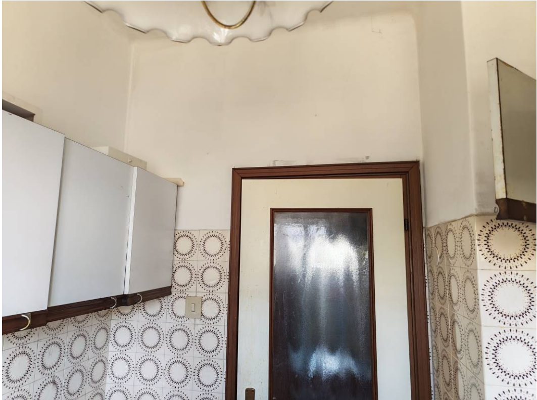
FOTO 73 – cucinino dell'alloggio (unità condominiale "8", subalterno catastale 13)
