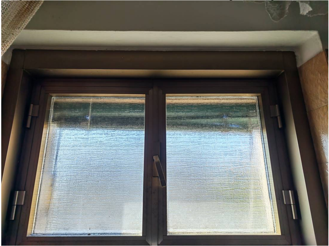
FOTO 57 – doccia-WC dell'alloggio (unità condominiale "8", subalterno catastale 13), particolare del serramento della finestra in alluminio privo di taglio termico
