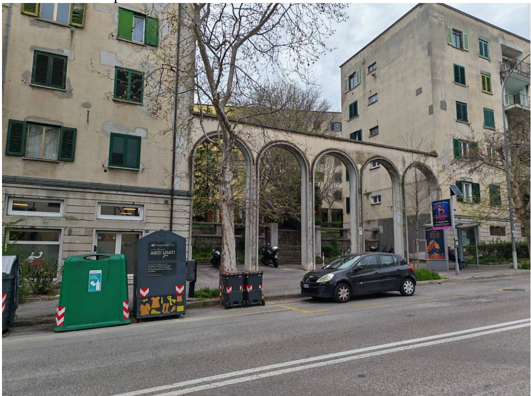
FOTO 4 – Immagine ripresa da Viale Campi Elisi: ingresso al complesso immobiliare di cui fa parte il condominio sito al civico n. 20; accesso al cortile identificato dalla p.c.n. 6133/3 del C.C. di Trieste
