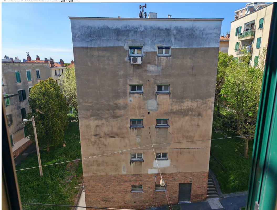
FOTO 42 – stanza da letto dell'alloggio (unità condominiale "8", subalterno catastale 13), particolare della vista dalla finestra che prospetta sulla Via Giambattista Morgagni
