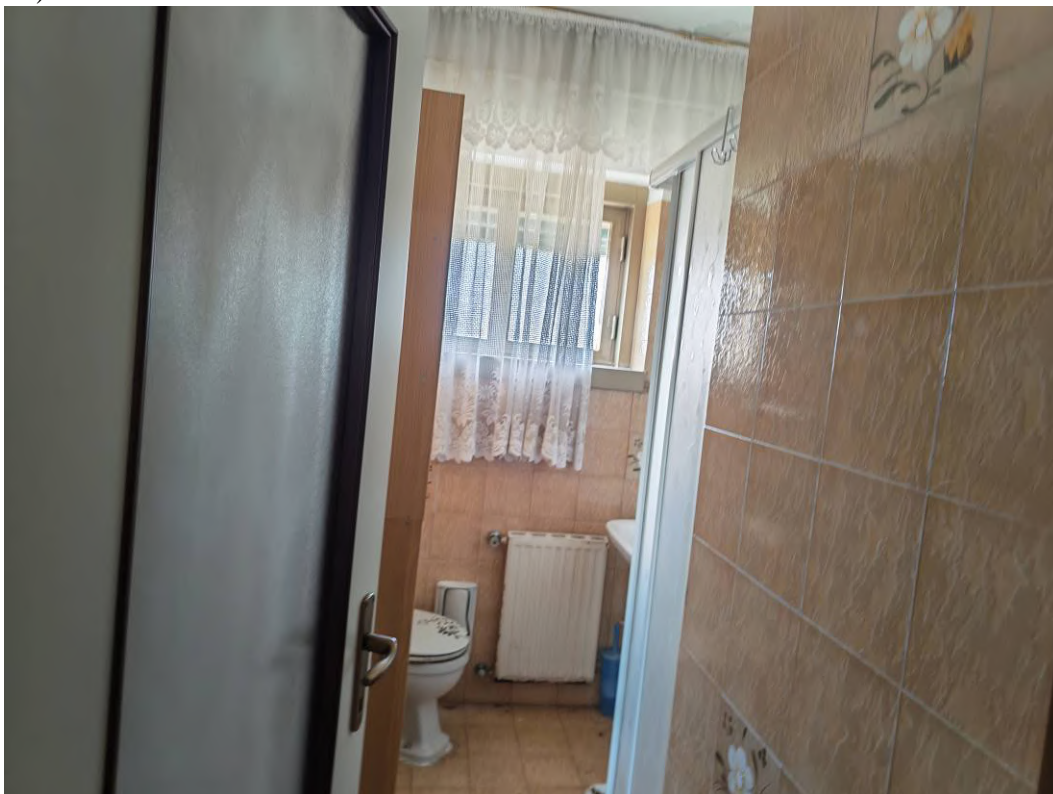
FOTO 54 – doccia-wc dell'alloggio (unità condominiale "8", subalterno catastale 13)
