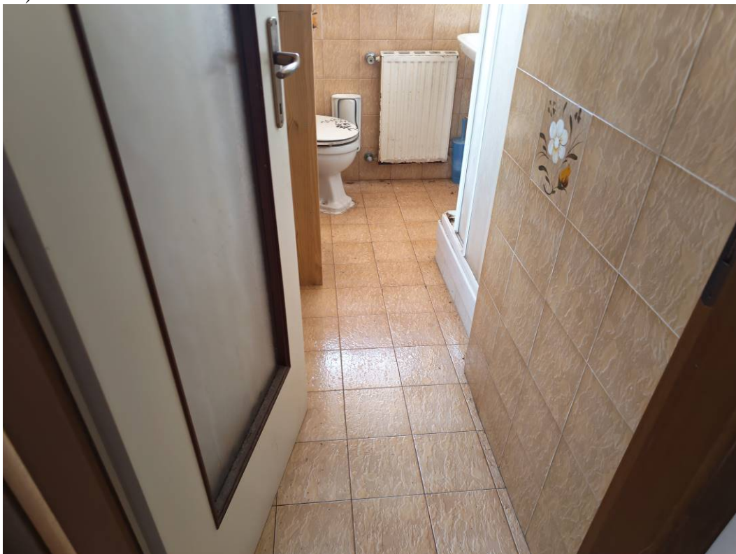
FOTO 53 – doccia-wc dell'alloggio (unità condominiale "8", subalterno catastale 13)
