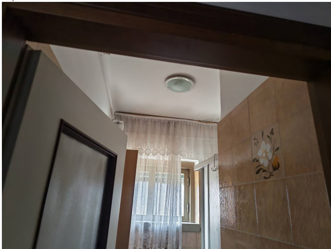
FOTO 55 – doccia-wc dell'alloggio (unità condominiale "8", subalterno catastale 13)
