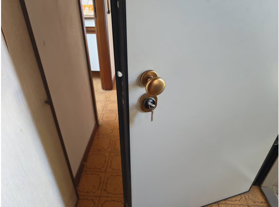
FOTO 33 – Corridoio dell'alloggio (unità condominiale "8", subalterno catastale 13); particolare del portoncino blindato
