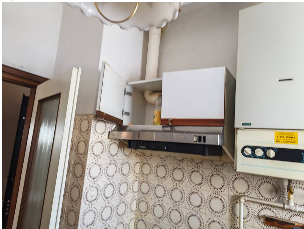
FOTO 67 – cucinino dell'alloggio (unità condominiale "8", subalterno catastale 13)
