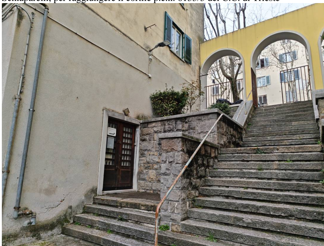
FOTO 17 – Complesso immobiliare di cui fa parte il condominio sito al civico n. 20, particolare della scalinata che è necessario scendere dalla Via Giovanni Schiaparelli, per raggiungere il cortile p.c.n. 6133/3 del C.C. di Trieste
