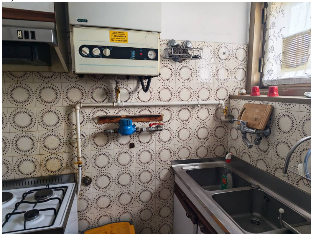
FOTO 70 – cucinino dell'alloggio (unità condominiale "8", subalterno catastale 13)
