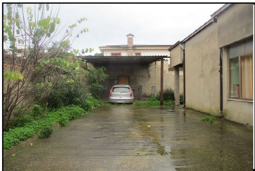
Foto n°7 -Cortile pavimentato. Lotto 1.
