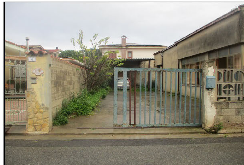
Foto n°2 - Ingresso carrabile Via Cesare Pavese Lotto 1
