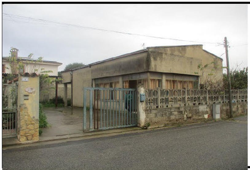
Foto n°1 - Ingresso carrabile Via Cesare Pavese. Lotto 1
