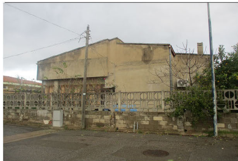
Foto n°6 - Via Cesare Pavese. Lotto 1.
