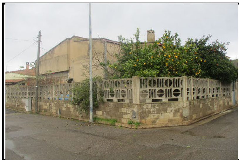
Foto n°3 - Prospetto. Via Cesare pavese. Lotto 1
