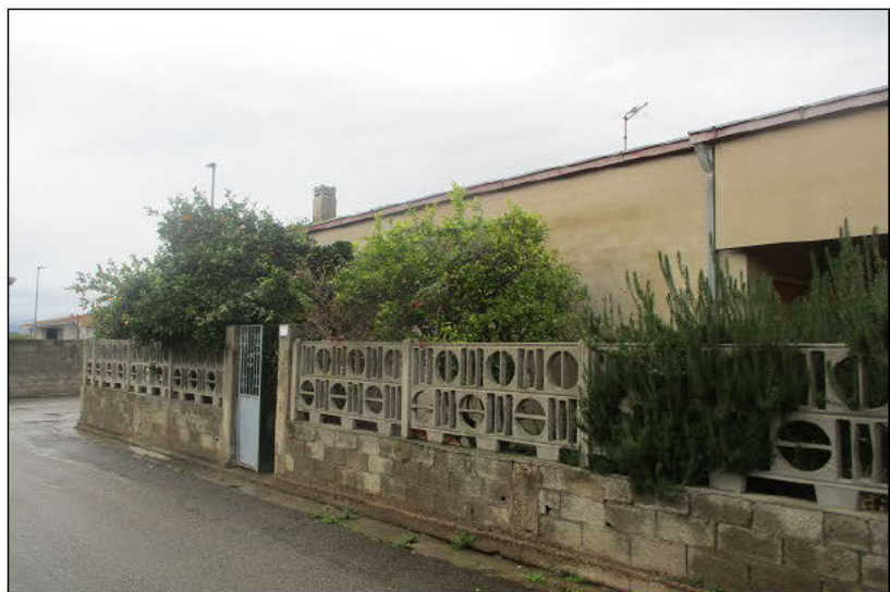
Foto n°5 - Via Cesare Pavese. Lotto 1.
