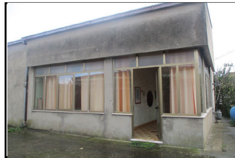
Foto n°8 - Ingresso. Veranda Chiusa. Lotto 1.
