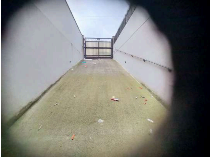
BCNC sub 2 Rampa di accesso ai box comune ai sub 9 e 10
