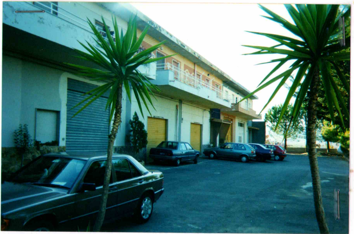
VISTA DALLA CORTE DEL PROSPETTO PRINCIPALE
