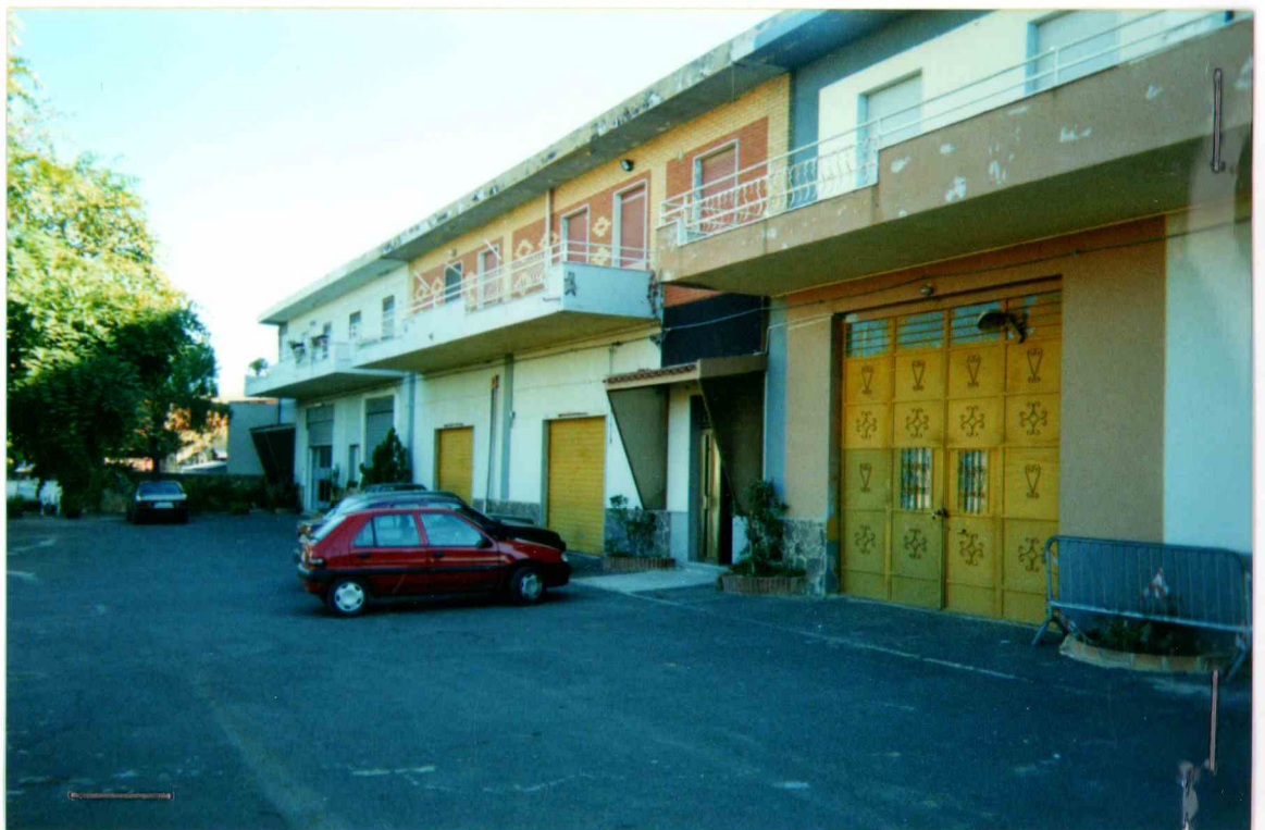
VISTA DALLA CORTE DEL PROSPETTO PRINCIPALE
