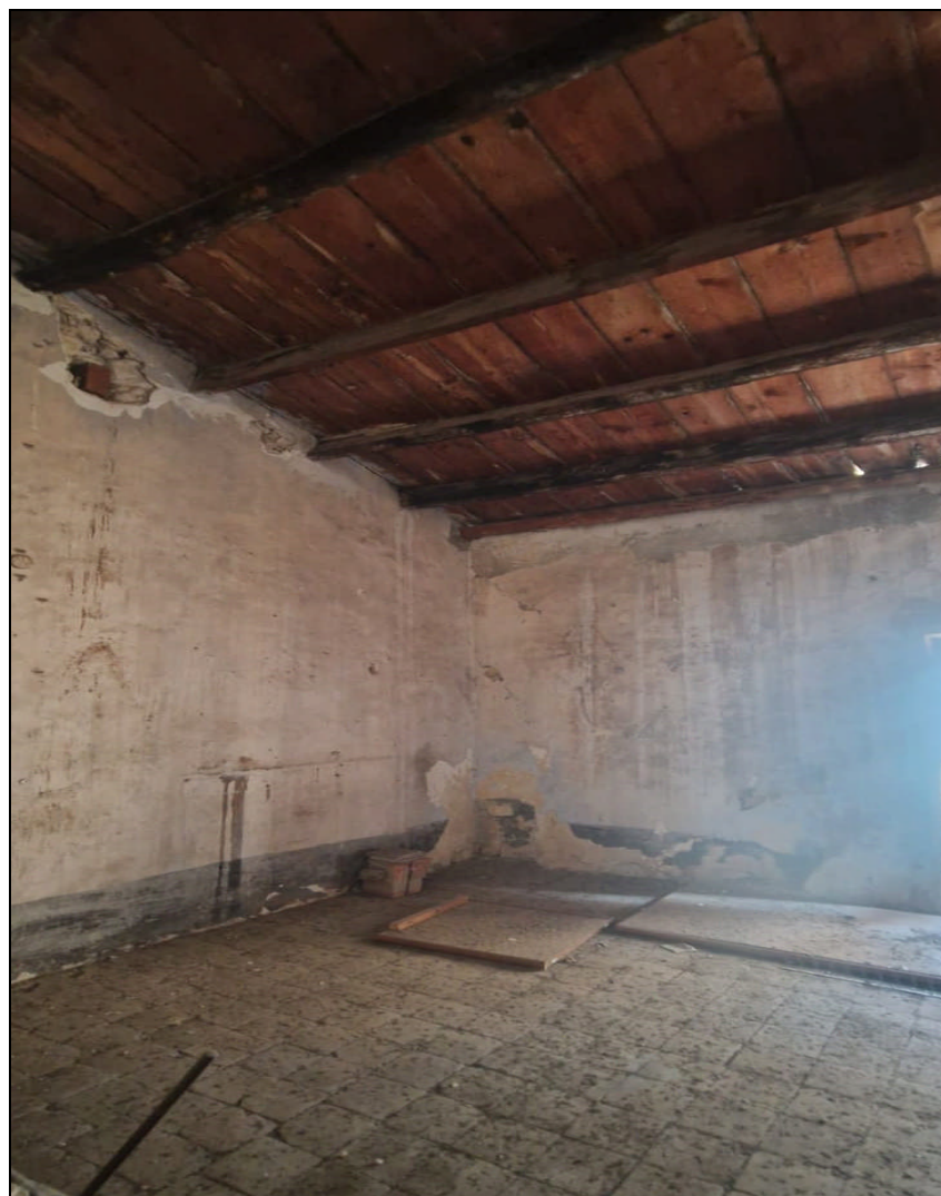
Foto 20: Particolare interno vano sgombero piano secondo
