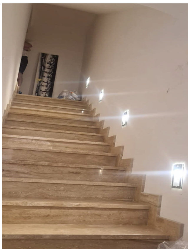
Foto 18: Particolare vano scala Appartamento vano primo
