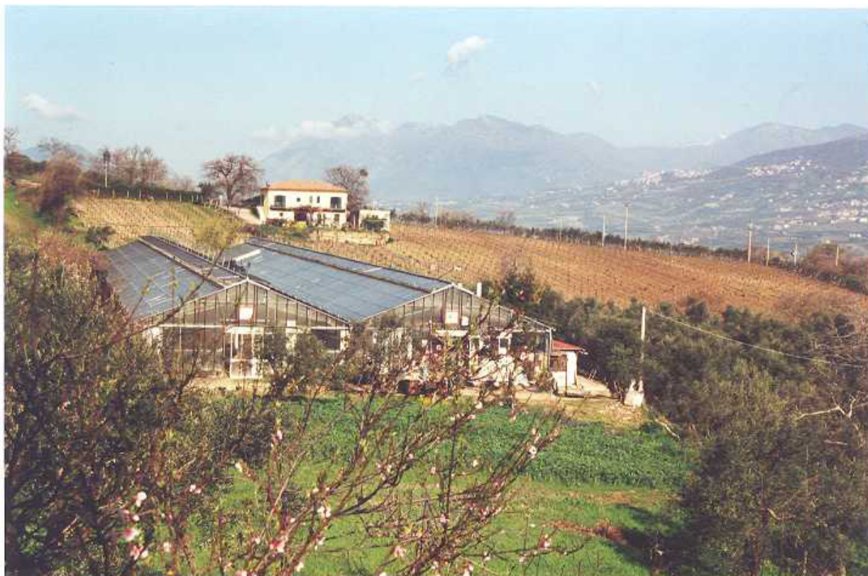
I 2 INGRESSI ALLE SERRE E IL FABBRICATO RURALE A DESTRA
