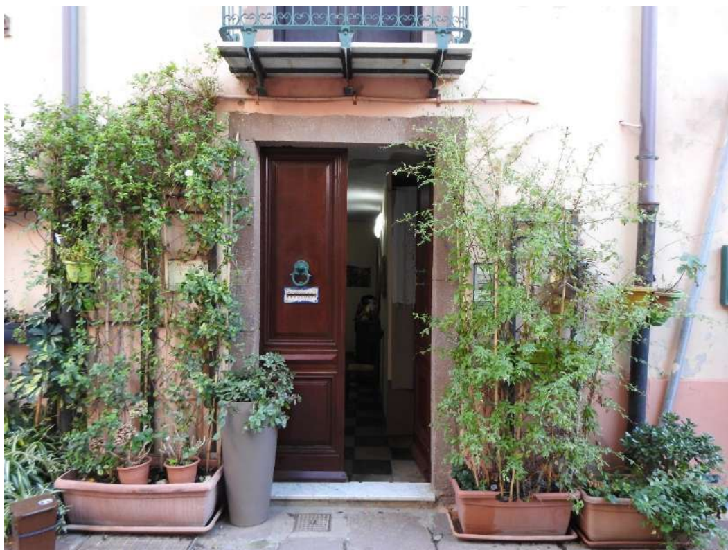
Figura 7 - Ingresso principale, corso Vittorio Emanuele II n.6
