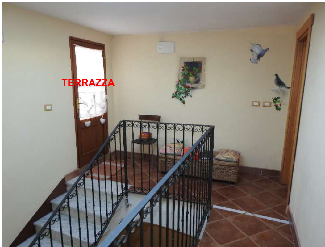
Figura 18 - Vano scala comune (BCNC sub. 11). Visuale del pianerottolo del quarto piano
