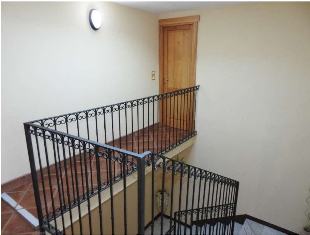
Figura 17 - Vano scala comune (BCNC sub. 11). Visuale del pianerottolo del quarto piano
