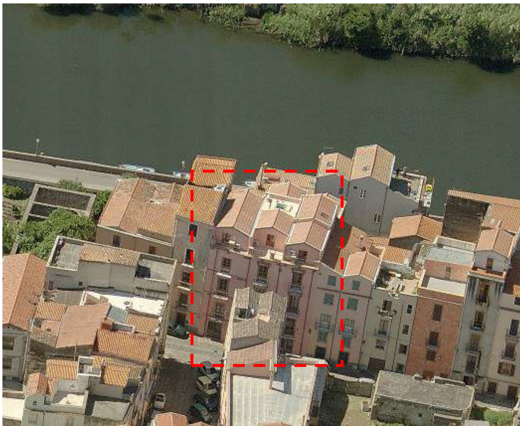
Figura 22 - Visuale assonometrica del fabbricato da nord verso sud
