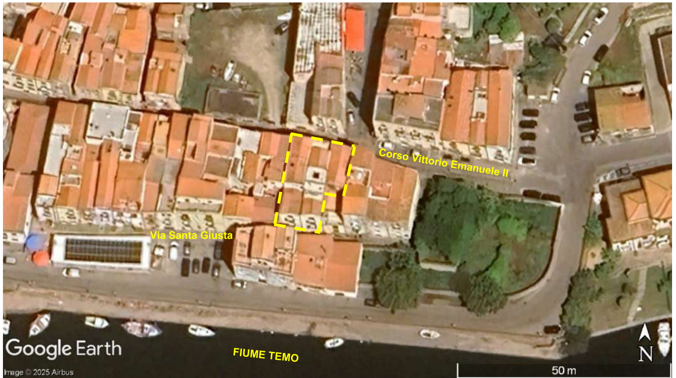
Figura 2 - Ortofoto dei luoghi, perimetro visibile del fabbricato
