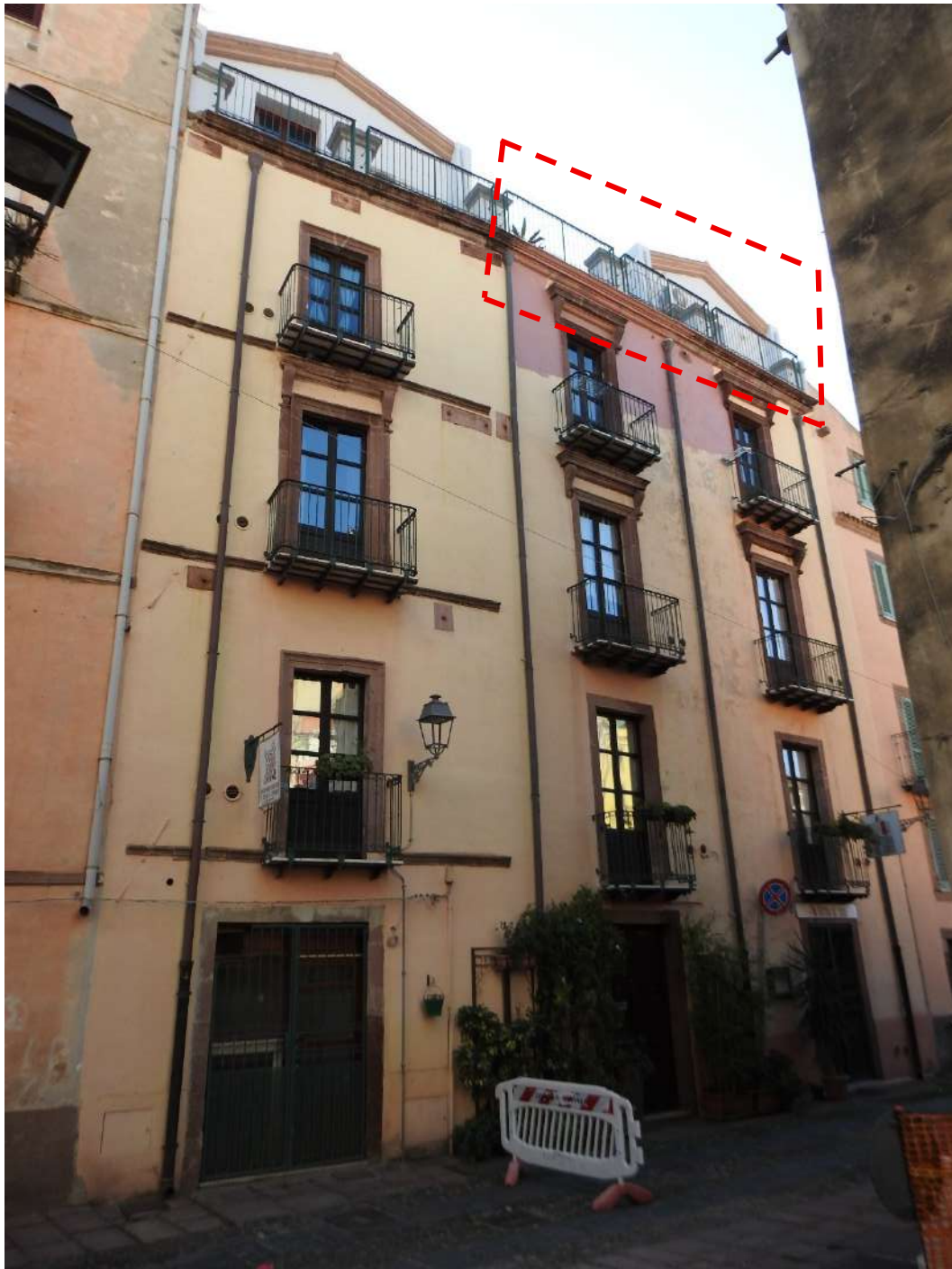
Figura 35 – Lotto 9, visuale esterna dal Corso Vittorio Emanuele II
