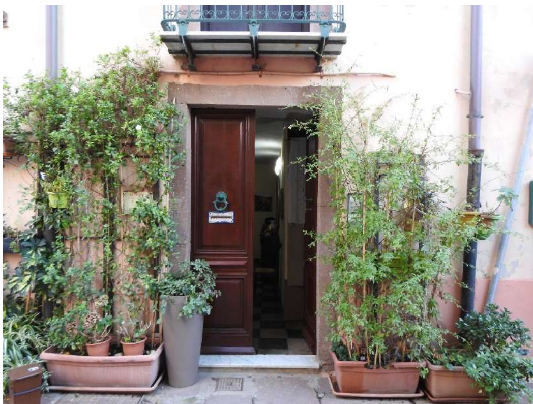
Figura 7 - Ingresso principale, corso Vittorio Emanuele II n.6
