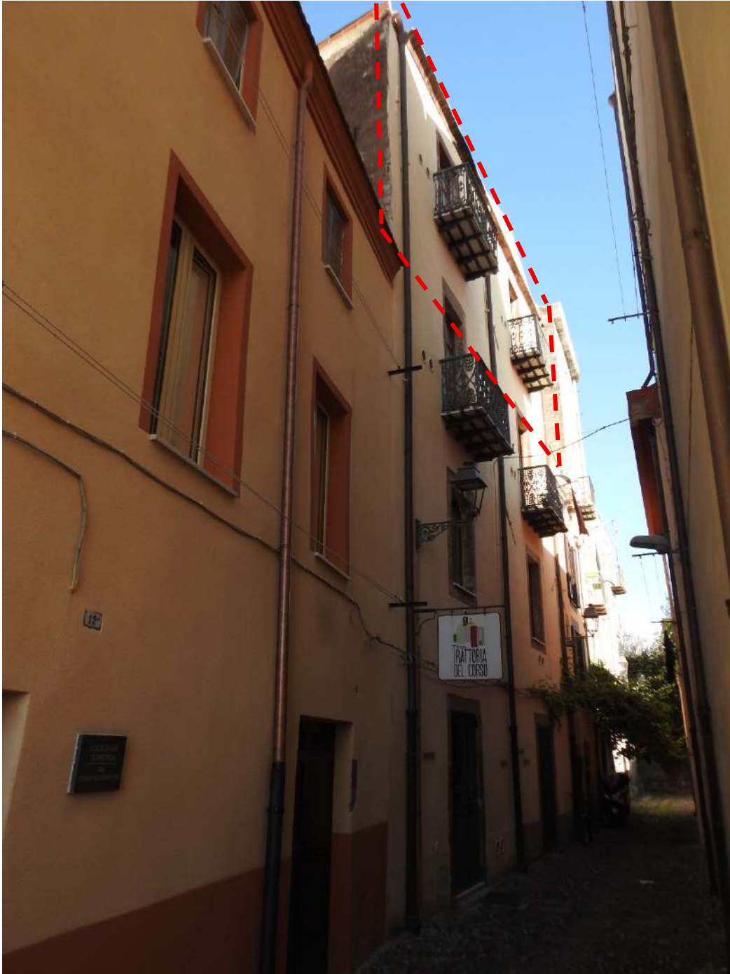
Figura 33 - Lotto 7, visuale esterna da via Santa Giusta
