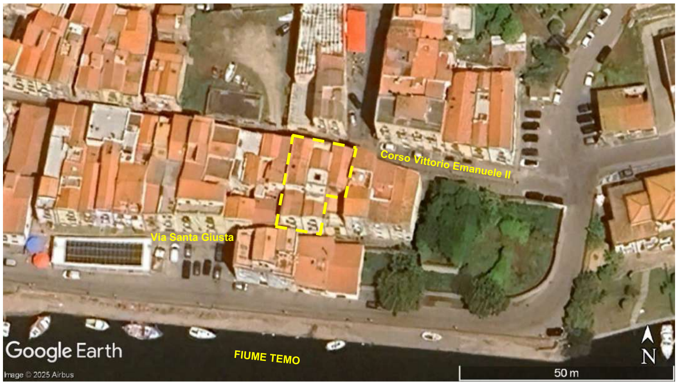
Figura 2 - Ortofoto dei luoghi, perimetro visibile del fabbricato
