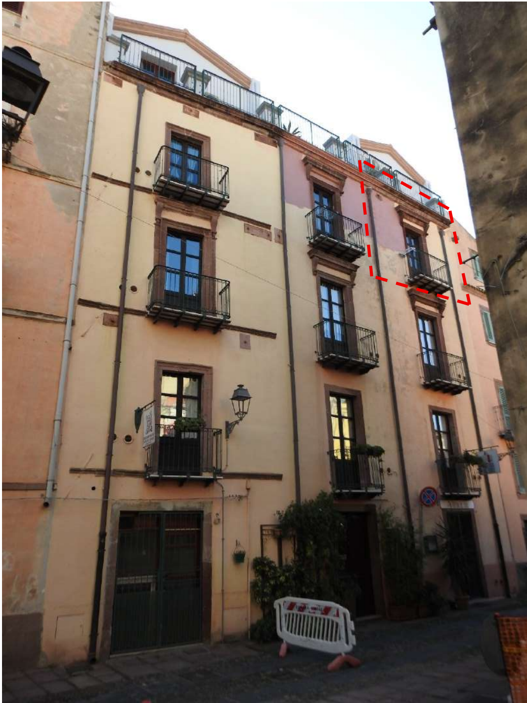
Figura 33 - Lotto 6, visuale esterna dal Corso Vittorio Emanuele II
