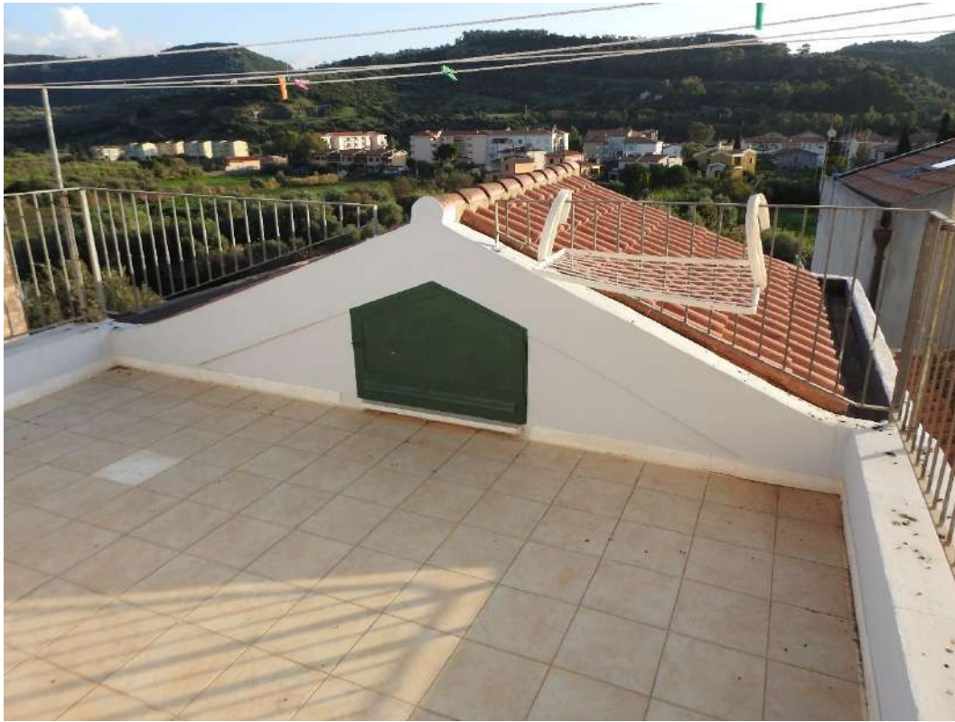
Figura 20 - Terrazza condominiale (abusiva). Visuale dalla porta finestra
