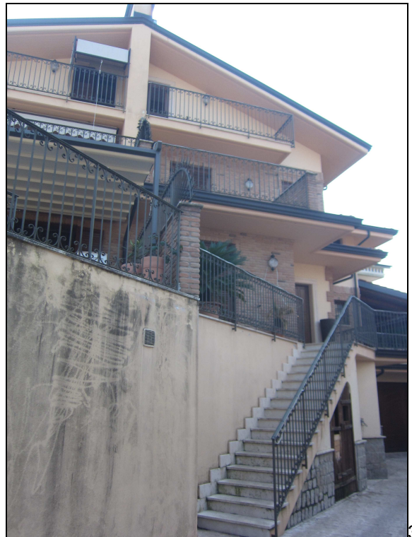
3 L'unità immobiliare è la porzione destra del fabbricato
