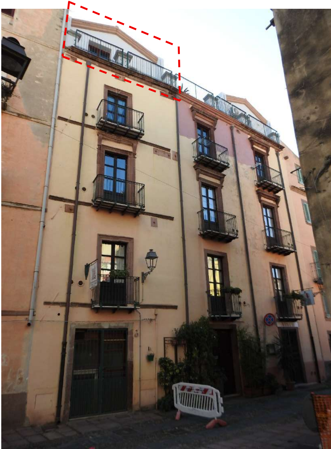
Figura 36 – Lotto 8, visuale esterna dal Corso Vittorio Emanuele II
