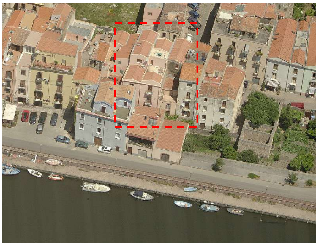
Figura 23 - Visuale assonometrica del fabbricato da sud verso nord
