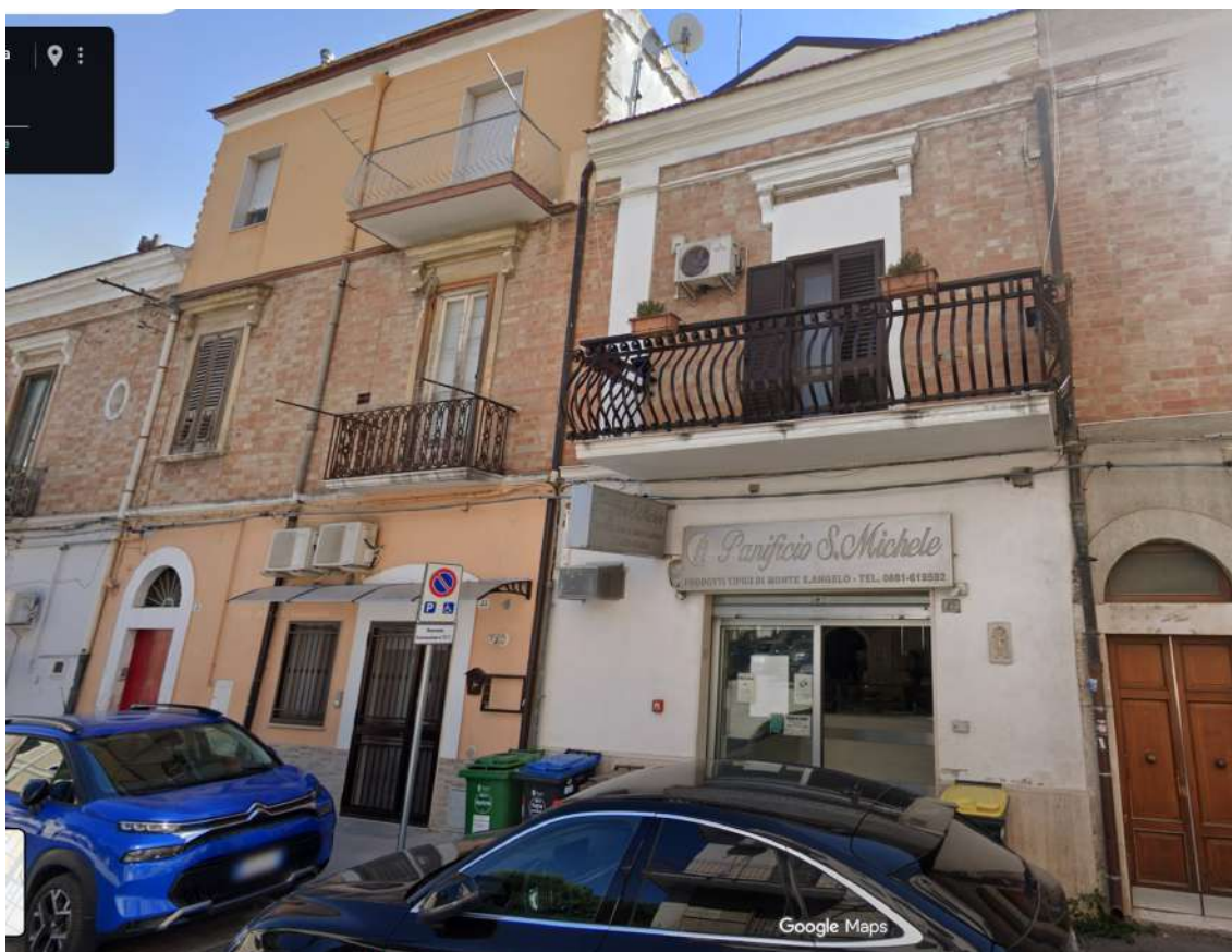
Foto n. 1 – Prospetto principale del fabbricato su via Marchese De Rosa
