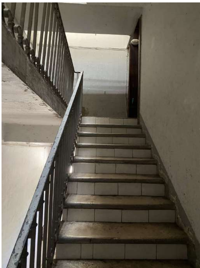
Foto n. 8 – Rampa di accesso al pianerottolo del 1° piano
