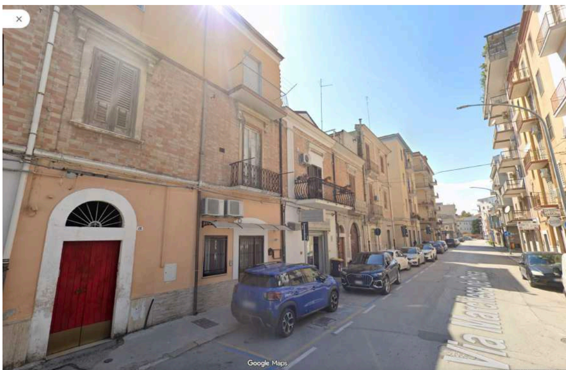
Foto n. 2 – Prospetto principale del fabbricato su via Marchese De Rosa
