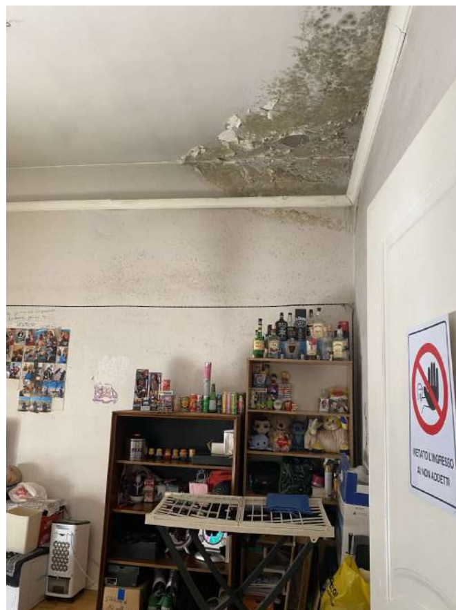
Foto n. 22 – Particolari del soffitto della seconda camera da letto
