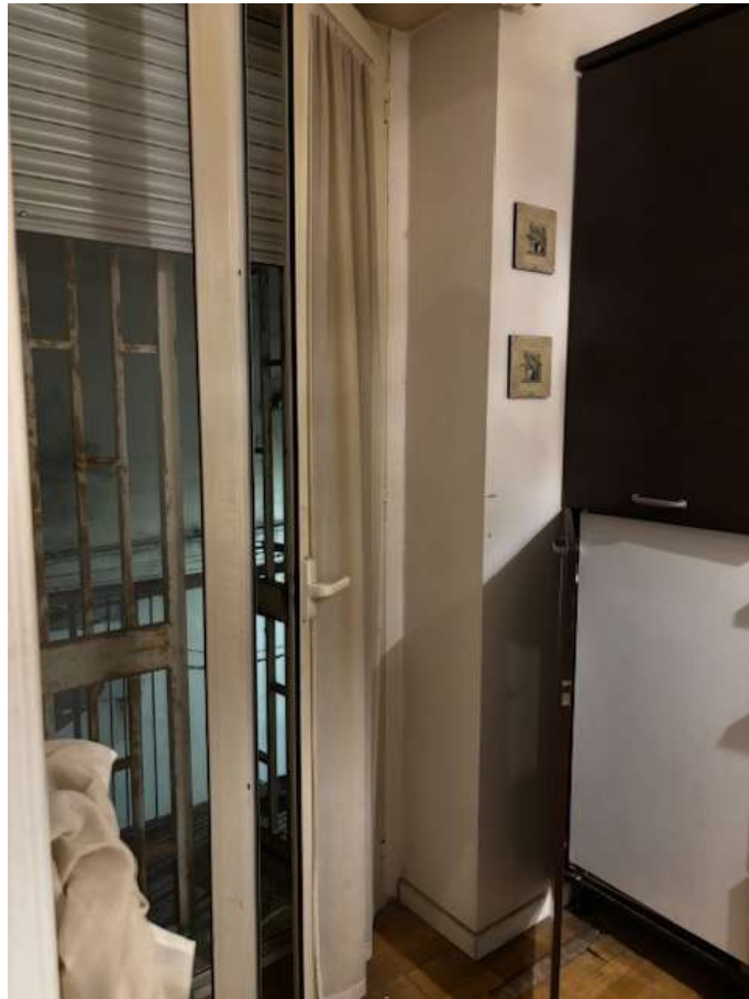
Foto n. 13 – Porta di accesso al balcone dalla cucina
