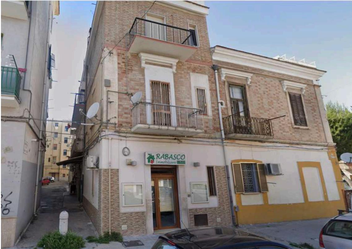
Foto n. 3 – Prospetto laterale del fabbricato su via Mogadiscio
