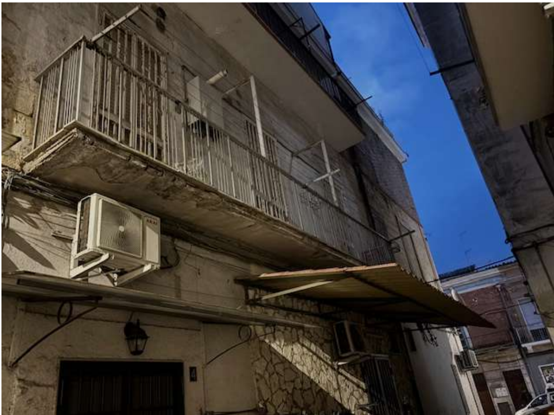
Foto n. 4 – Prospetto posteriore del fabbricato su Cortile Via Mogadiscio
