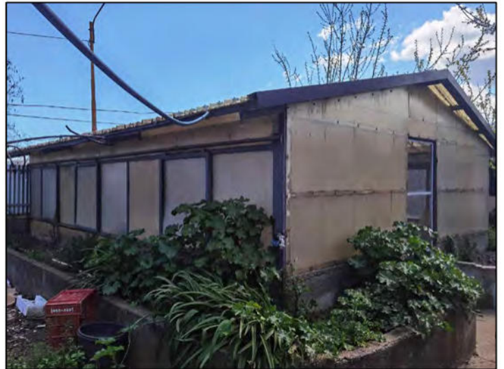
FOTO 288 - Lotto 5 - Fabbricato con struttura portante metallica
