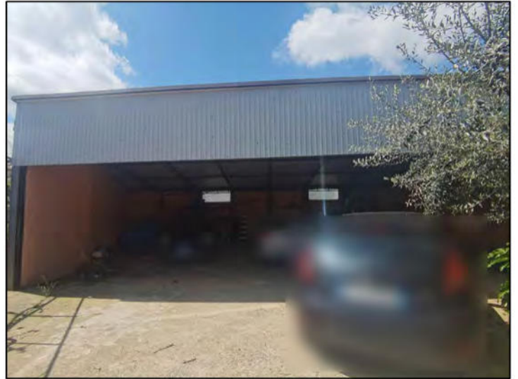
FOTO 286 - Lotto 5 - Esterni (Tettoia ad uso posti auto)
