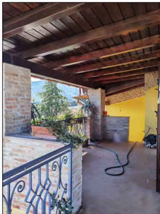
FOTO 278 - Lotto 5 - Esterni (Tettoia al piano primo)
