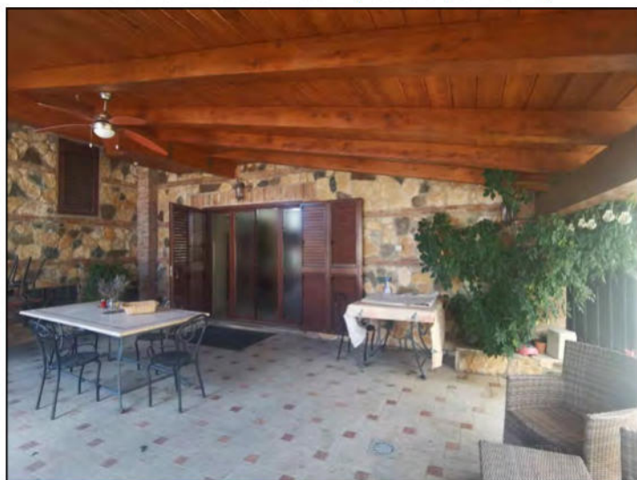
FOTO 281 - Lotto 5 - Esterni (Tettoia al piano terra)
