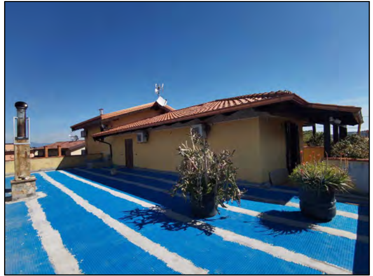
FOTO 280 - Lotto 5 - Esterni (Terrazza al piano primo)
