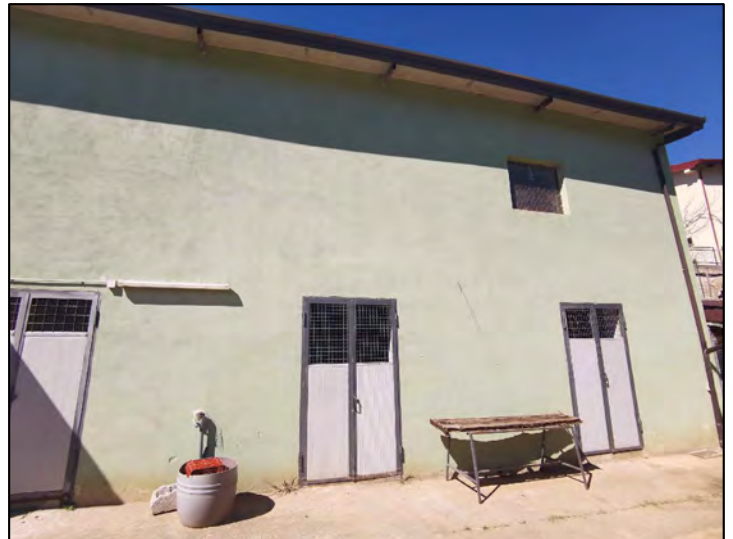
FOTO 161 - Lotto 2 - Corpo Z - Fabbricato Conigliera-Fienile (Esterni)
