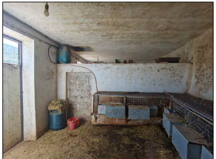
FOTO 163 - Lotto 2 - Corpo Z - Fabbricato Conigliera-Fienile (Piano Seminterrato - Interni)
