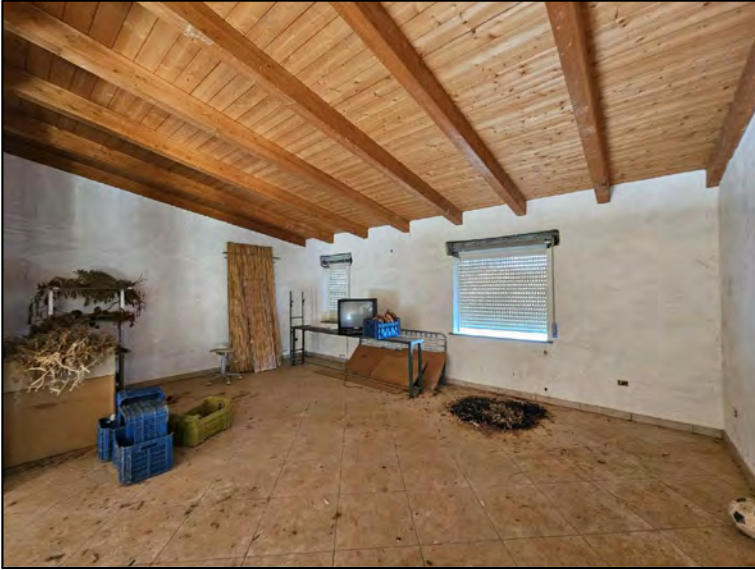
FOTO 106 - Lotto 2 - Corpo Y - Appartamento B (Soggiorno-Pranzo-Cucina)
