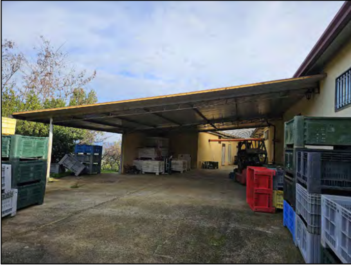
FOTO 134 - Lotto 2 - Corpo Z - Tettoia sul lato Nord-Ovest del Capannone
