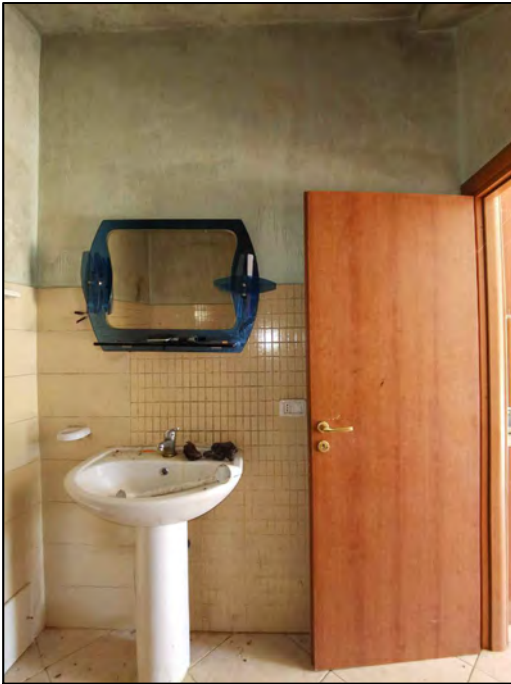
FOTO 170 - Lotto 2 - Corpo Z1 - Interni (Bagno)
