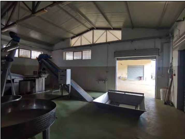
FOTO 118 - Lotto 2 - Corpo Z - Capannone (interni piano terra)
