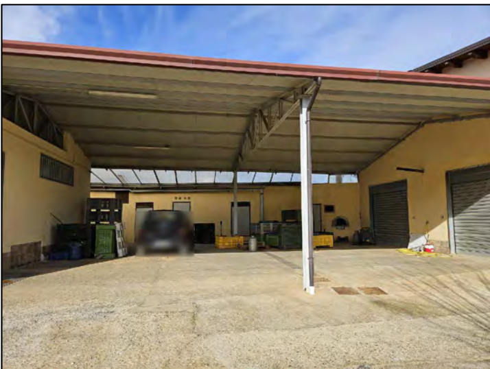
FOTO 132 - Lotto 2 - Corpo Z - Tettoia sul lato Nord-Est del Capannone
