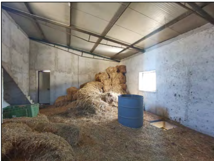
FOTO 162 - Lotto 2 - Corpo Z - Fabbricato Conigliera-Fienile (Piano Terra - Interni)
