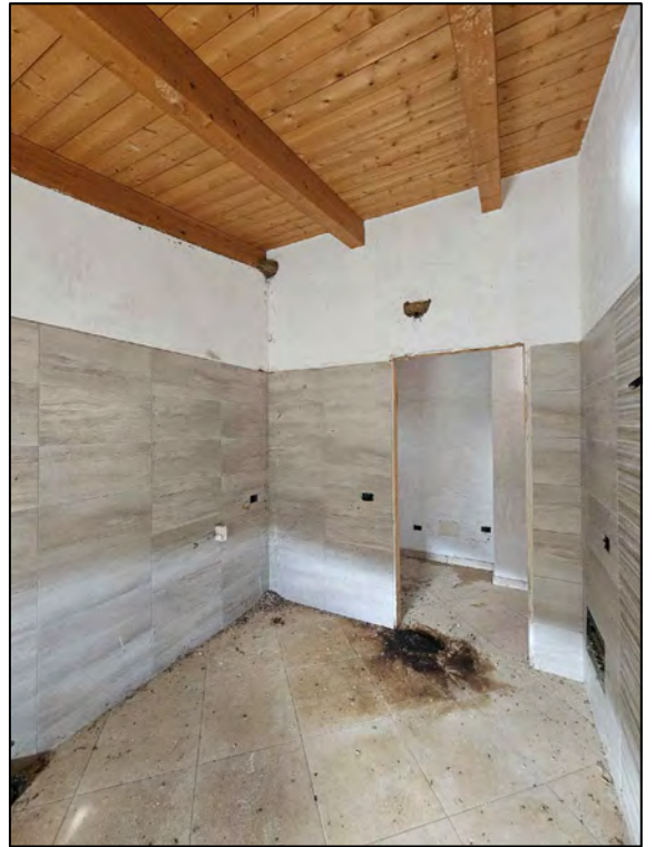
FOTO 112 - Lotto 2 - Corpo Y - Appartamento B (Bagno)
