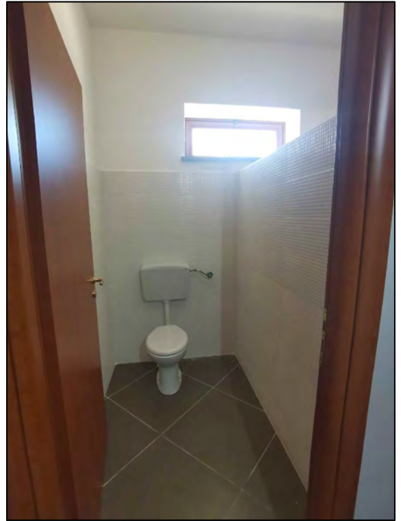
FOTO 74 - Lotto 2 - Corpo X - Interni (bagno - Piano Terra)
