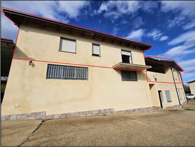
FOTO 87 - Lotto 2 - Corpo Y - Esterni
