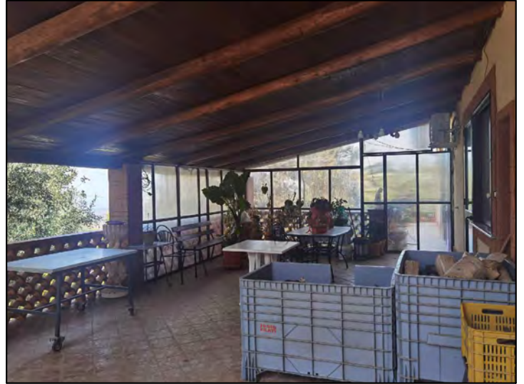
FOTO 223 - Lotto 4 - Corpo A - Esterni piano terra (tettoia)
