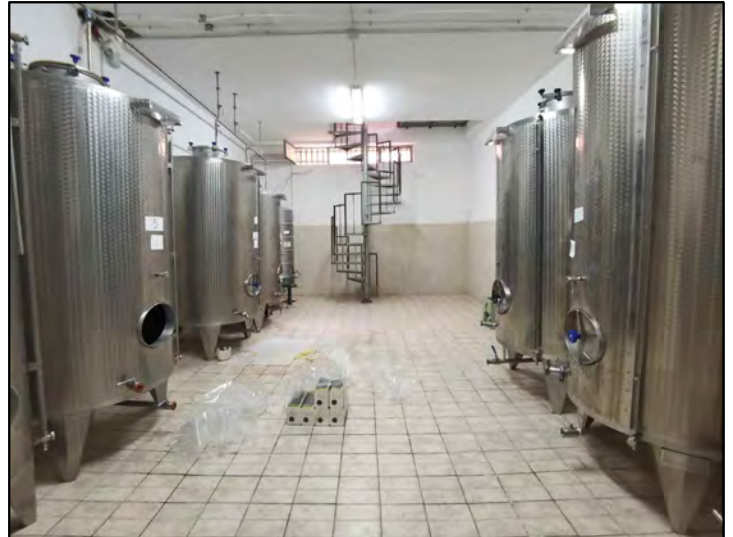
FOTO 131 - Lotto 2 - Corpo Z - Capannone (interni piano seminterrato)
