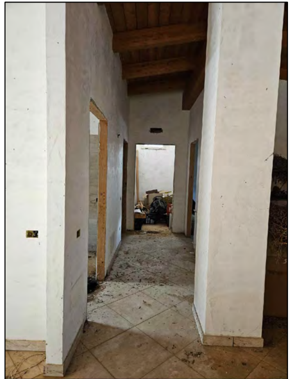
FOTO 105 - Lotto 2 - Corpo Y - Appartamento B (Corridoio)
