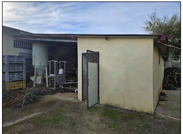
FOTO 133 - Lotto 2 - Corpo Z - Tettoia sul lato Nord-Ovest Capannone ed annesso locali deposito)
