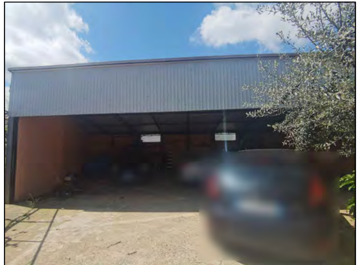
FOTO 286 - Lotto 5 - Esterni (Tettoia ad uso posti auto)
