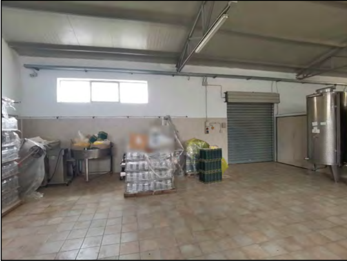
FOTO 122 - Lotto 2 - Corpo Z - Capannone (interni piano terra)
