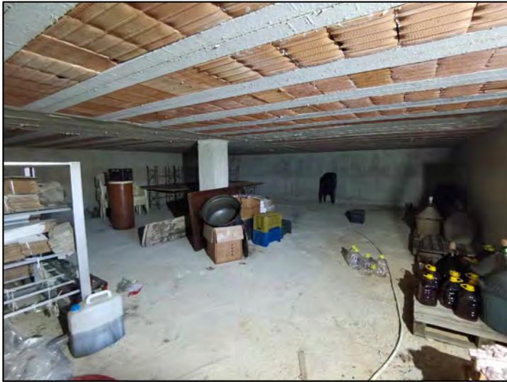
FOTO 158 - Lotto 2 - Corpo Z - Fabbricato con Locale Mensa (piano seminterrato - Interni)
