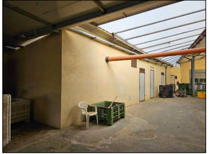
FOTO 135 - Lotto 2 - Corpo Z - Piano terra del fabbricato a 2 livelli sul lato Nord-Ovest del Capannone
