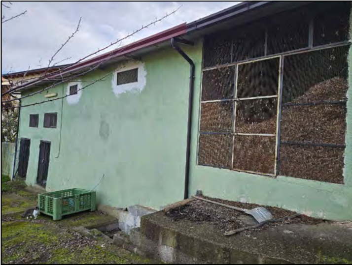
FOTO 136 - Lotto 2 - Corpo Z - Fabbricato a 2 livelli sul lato Nord-Ovest del Capannone
