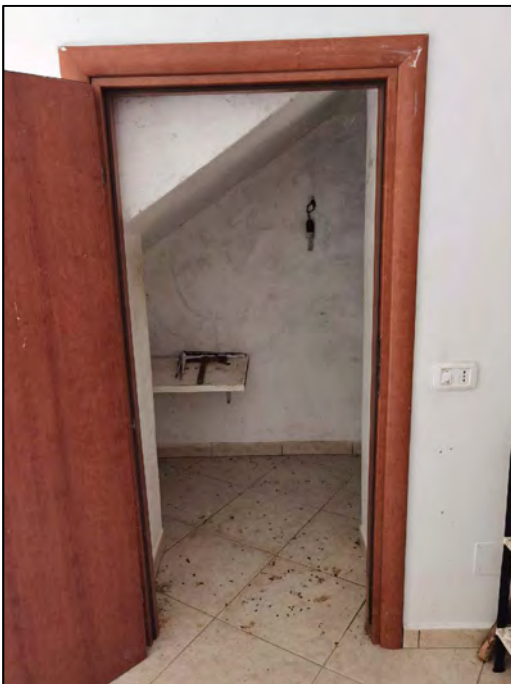
FOTO 171A - Lotto 2 - Corpo Z1 - Interni (ingresso al ripostiglio - sottoscala)
