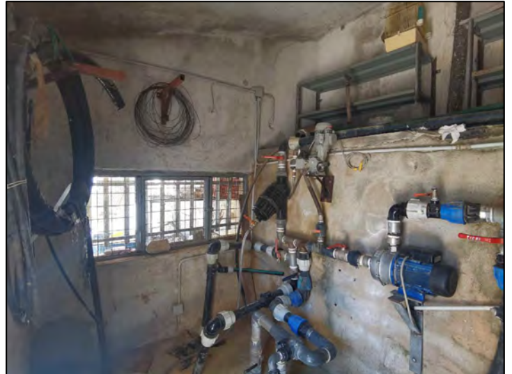
FOTO 176 - Lotto 2 - Corpo Z2 - Interni
