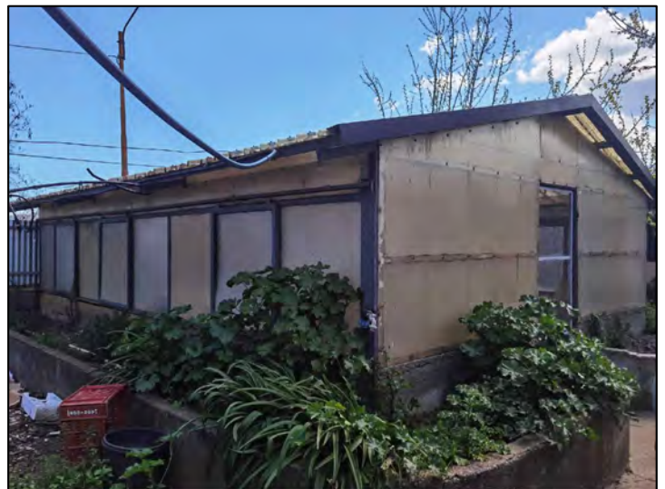
FOTO 288 - Lotto 5 - Fabbricato con struttura portante metallica
