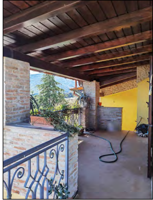
FOTO 278 - Lotto 5 - Esterni (Tettoia al piano primo)
