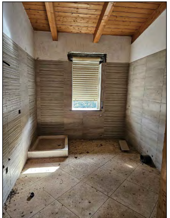
FOTO 114 - Lotto 2 - Corpo Y - Appartamento B (Bagno)
