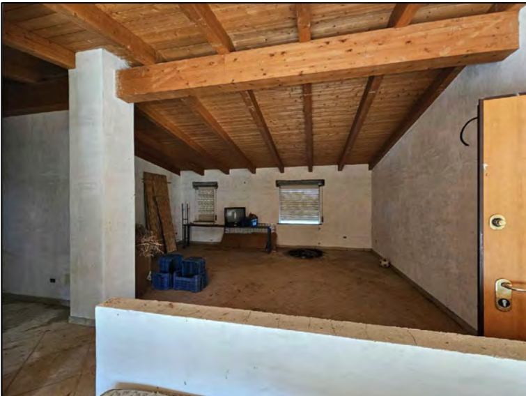
FOTO 108 - Lotto 2 - Corpo Y - Appartamento B (Soggiorno-Pranzo-Cucina)
