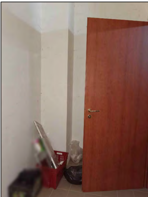
FOTO 156 - Lotto 2 - Corpo Z - Fabbricato con Locale Mensa (piano terra - Anti-Bagno)
