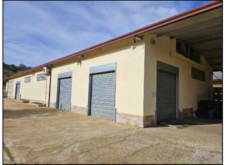
FOTO 117 - Lotto 2 - Corpo Z - Capannone (Esterni)
