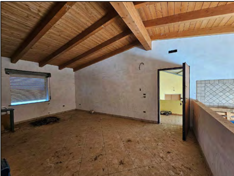
FOTO 110 - Lotto 2 - Corpo Y - Appartamento B (Soggiorno-Pranzo-Cucina)
