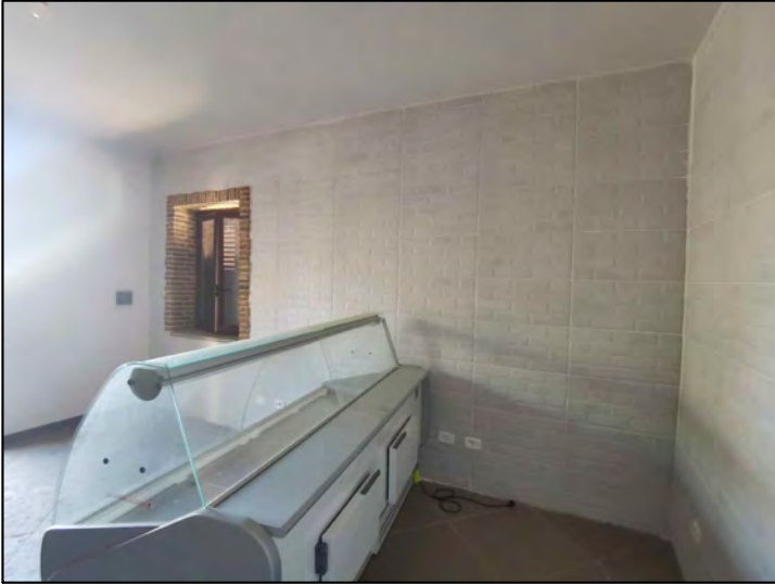
FOTO 68 - Lotto 2 - Corpo X - Interni (spaccio aziendale)
