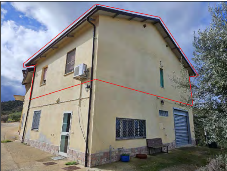
FOTO 89 - Lotto 2 - Corpo Y - Esterni
