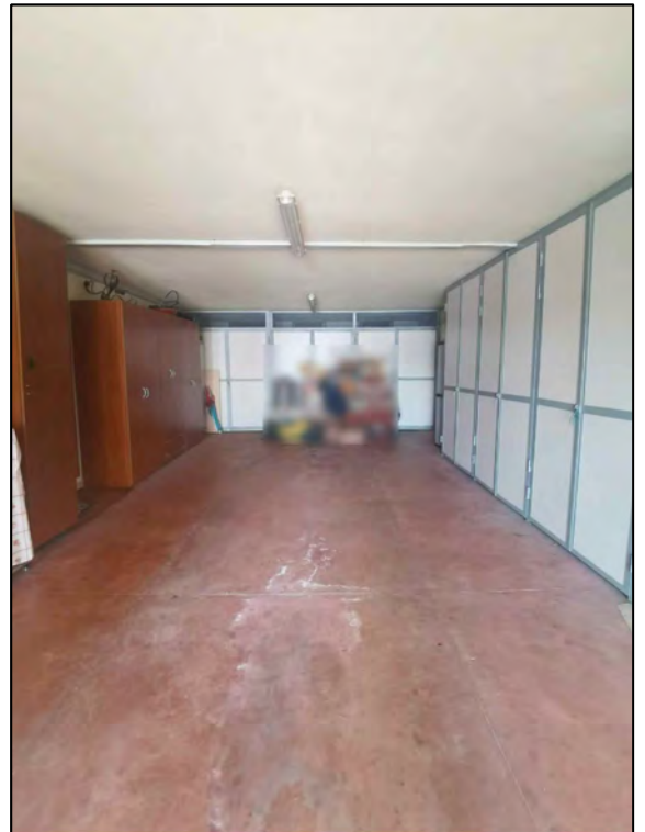
FOTO 198 - Lotto 4 - Corpo A Interni piano seminterrato (Box Auto 1)
