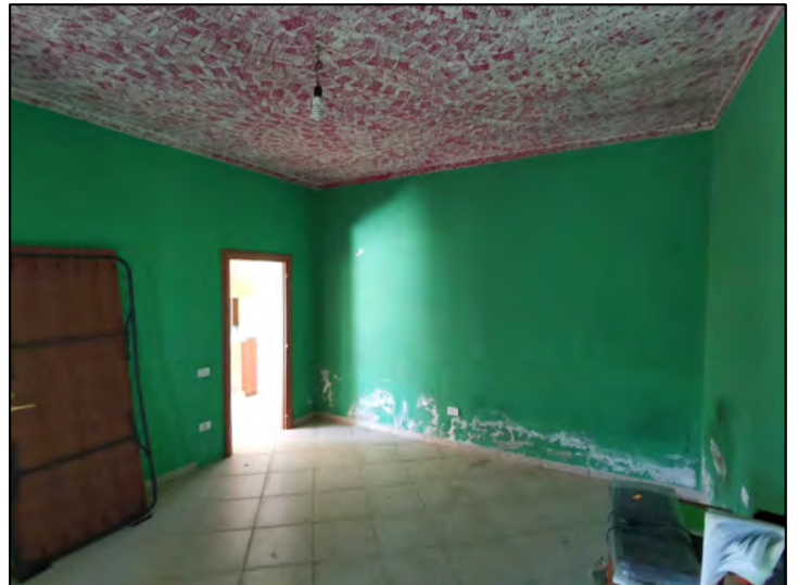
FOTO 167 - Lotto 2 - Corpo Z1 - Interni (Camera da letto matrimoniale)
