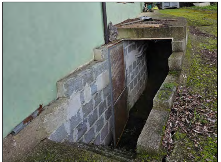
FOTO 139 - Lotto 2 - Corpo Z - Ingresso al locale tecnico del Fabbricato a 2 livelli sul lato Nord-Ovest del Capannone
