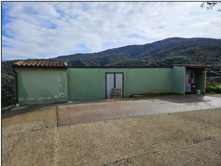
FOTO 160 - Lotto 2 - Corpo Z - Fabbricato Conigliera-Fienile (Esterni)
