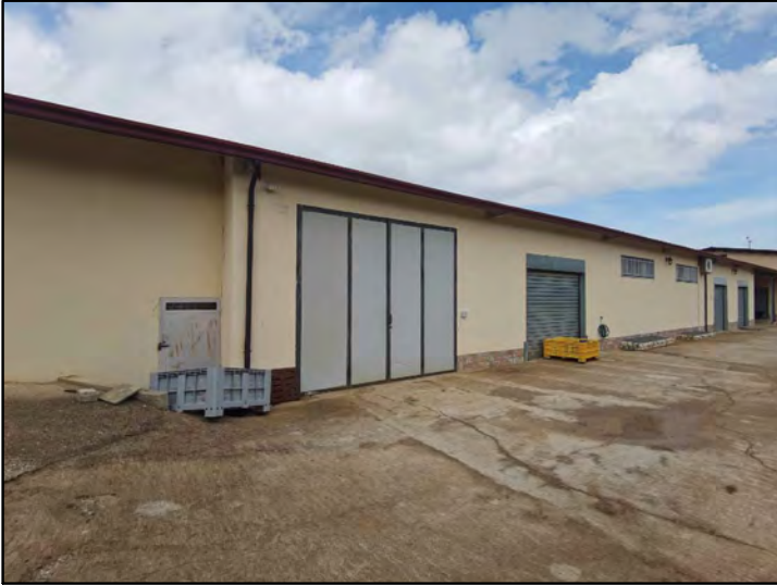
FOTO 116 - Lotto 2 - Corpo Z - Capannone (Esterni)
