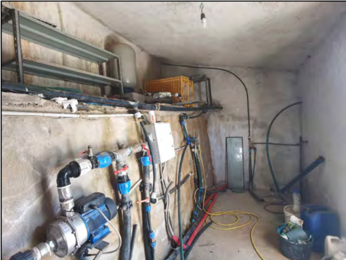
FOTO 175 - Lotto 2 - Corpo Z2 - Interni
