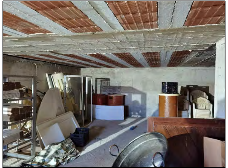
FOTO 159 - Lotto 2 - Corpo Z - Fabbricato con Locale Mensa (piano seminterrato - Interni)
