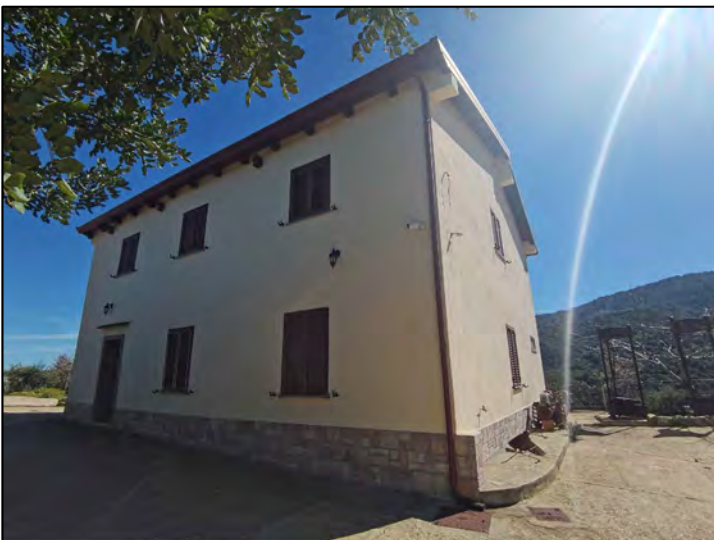
FOTO 66 - Lotto 2 - Corpo X - Esterni
