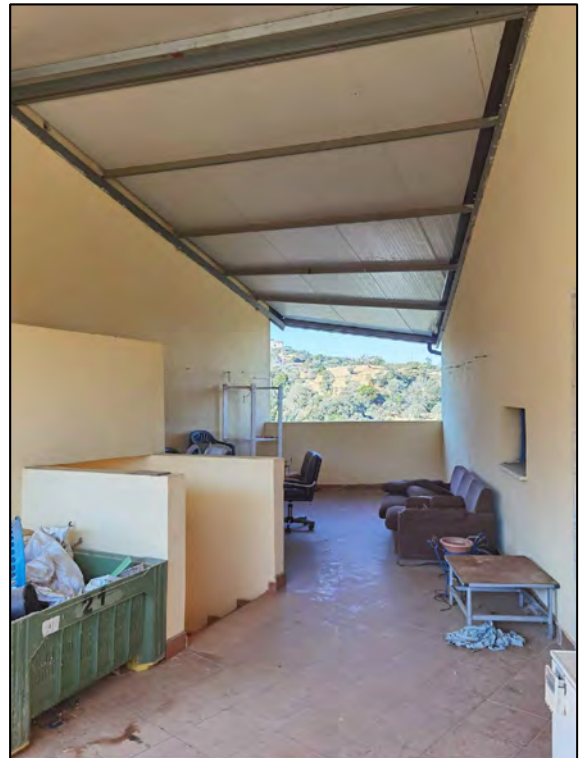
FOTO 90 - Lotto 2 - Corpo Y - Pianerottolo/terrazzo coperto
