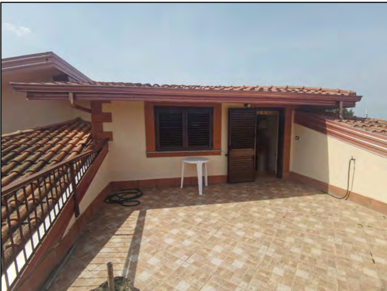
FOTO 221 - Lotto 4 - Corpo A - Esterni piano primo (Terrazza)
