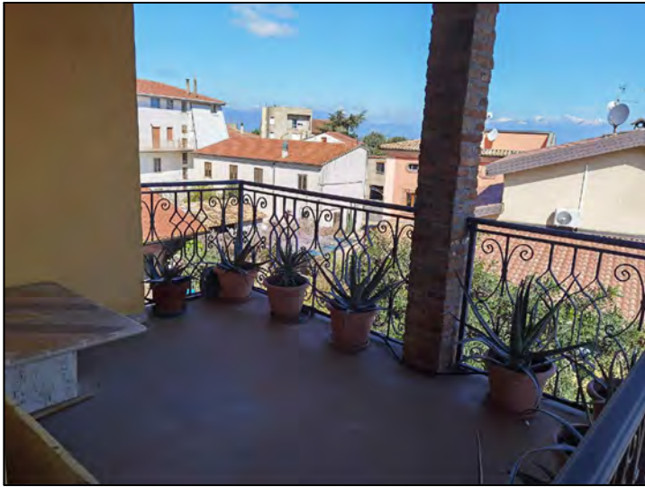
FOTO 279 - Lotto 5 - Esterni (Terrazzino al piano primo)
