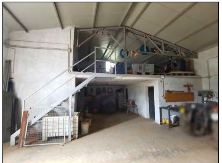
FOTO 121 - Lotto 2 - Corpo Z - Capannone (interni piano terra)
