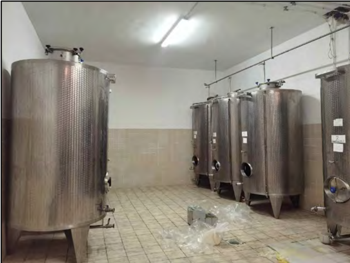
FOTO 130 - Lotto 2 - Corpo Z - Capannone (interni piano seminterrato)
