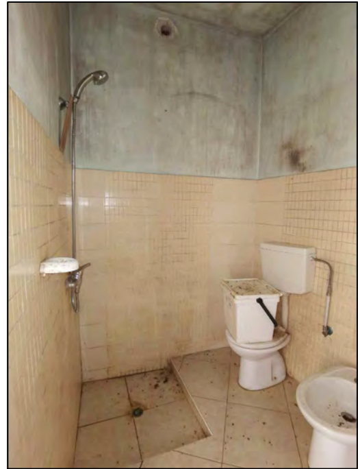
FOTO 171 - Lotto 2 - Corpo Z1 - Interni (Bagno)
