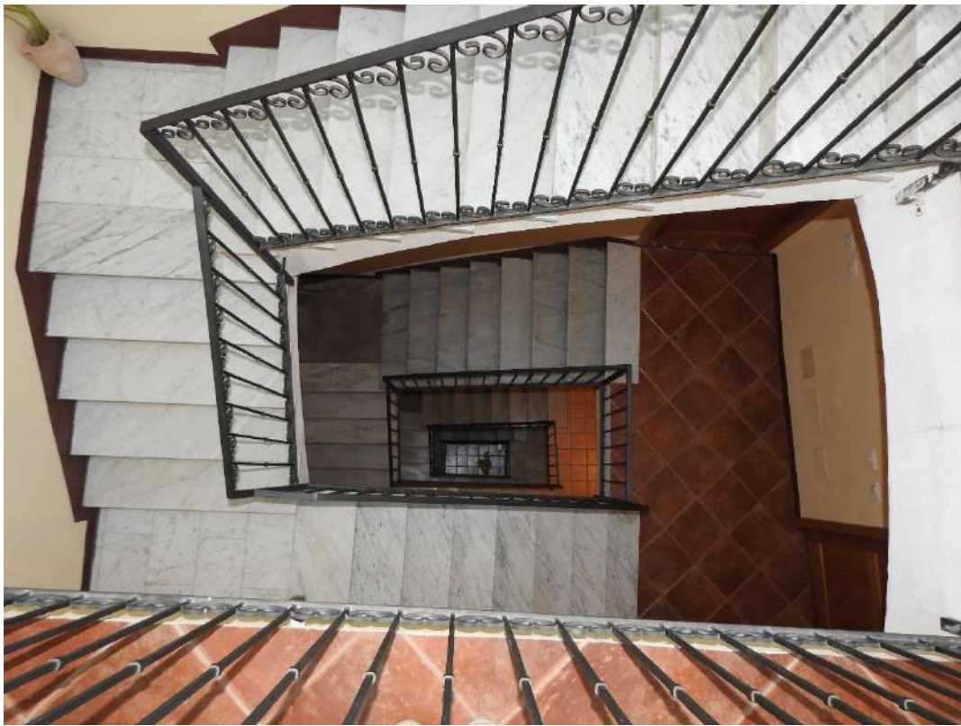
Figura 19 - Vano scala comune (BCNC sub. 11). Visuale dall'alto
