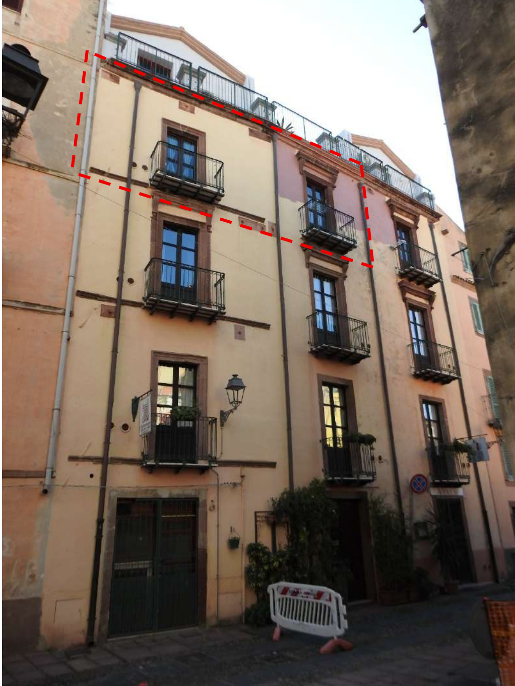
Figura 33 - Lotto 5, visuale esterna dal Corso Vittorio Emanuele II
