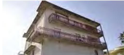
Vista esterna retro prospetto
