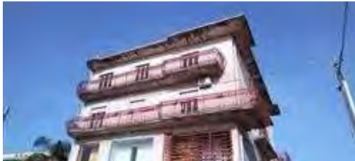
Vista esterna fronte strada principale
