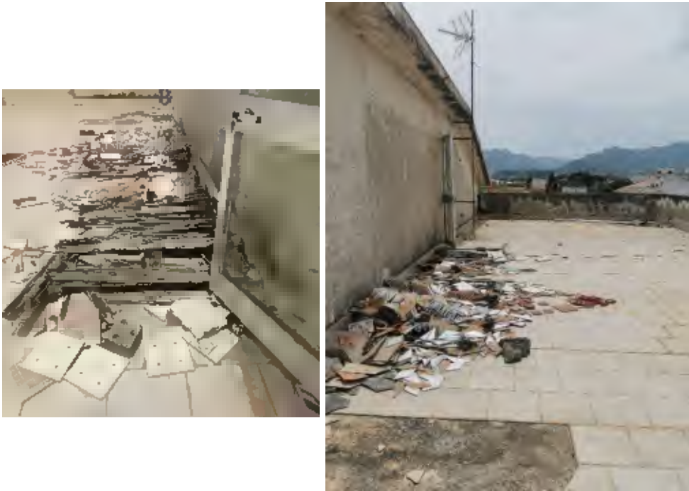
Piano quarto Lastrico solare
