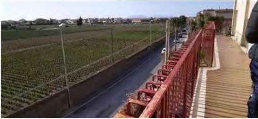
Vista esterna - prospetto principale
