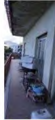
Vista esterna - retro prospetto
