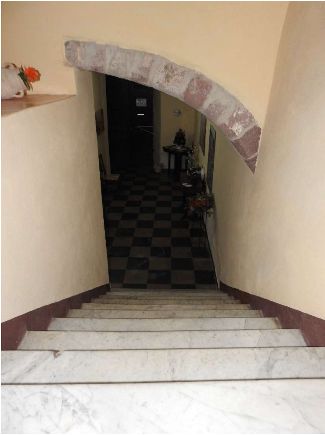
Figura 12 - Vano scala comune (BCNC sub. 11). Visuale dal primo pianerottolo verso l'androne di ingresso
