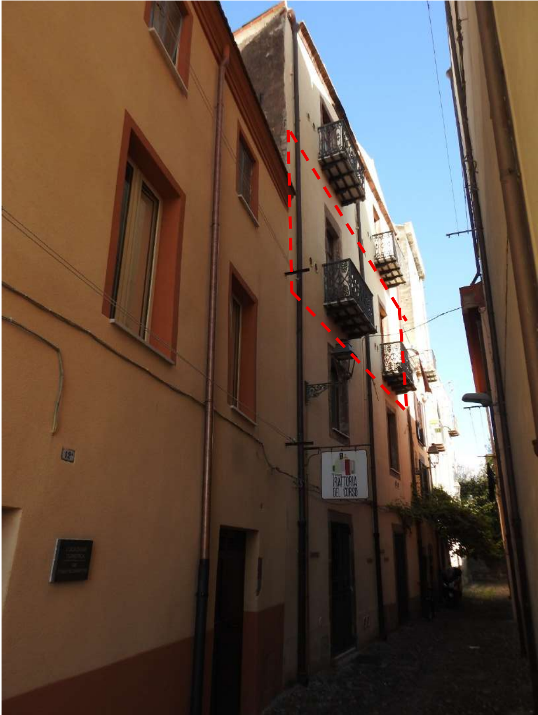
Figura 33 - Lotto 4, visuale esterna da via Santa Giusta
