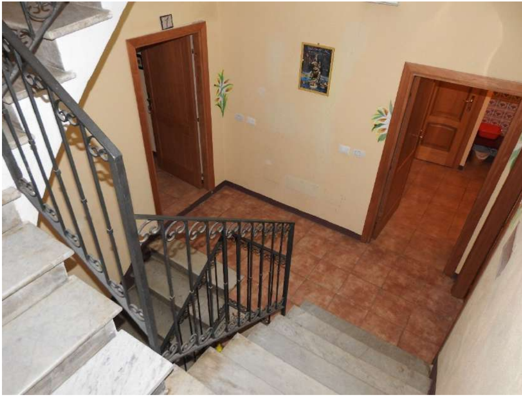
Figura 13 - Vano scala comune (BCNC sub. 11). Visuale del pianerottolo del primo piano
