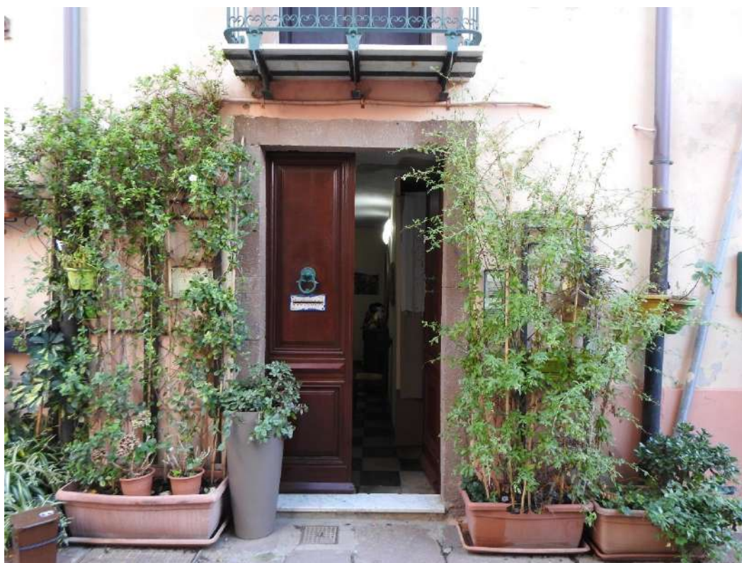
Figura 7 - Ingresso principale, corso Vittorio Emanuele II n.6
