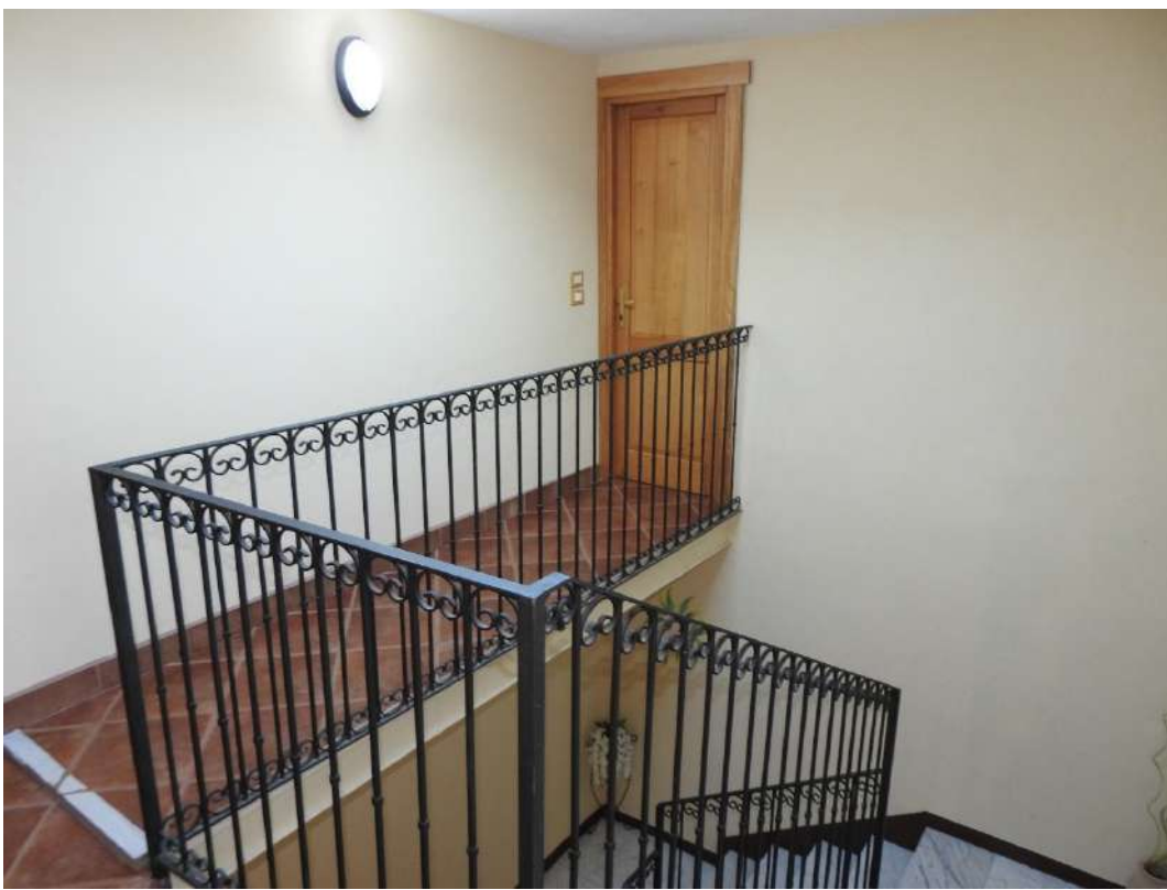
Figura 17 - Vano scala comune (BCNC sub. 11). Visuale del pianerottolo del quarto piano
