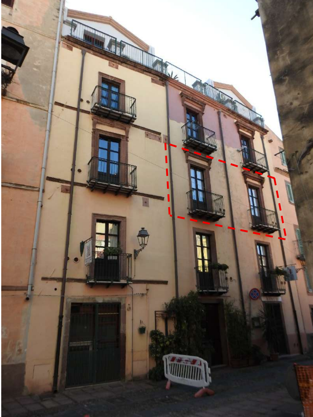
Figura 33 - Lotto 3, visuale esterna dal Corso Vittorio Emanuele II
