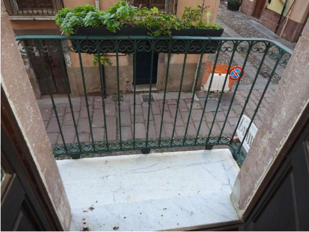
Figura 57 - Poggiolo soggiorno interno 3
