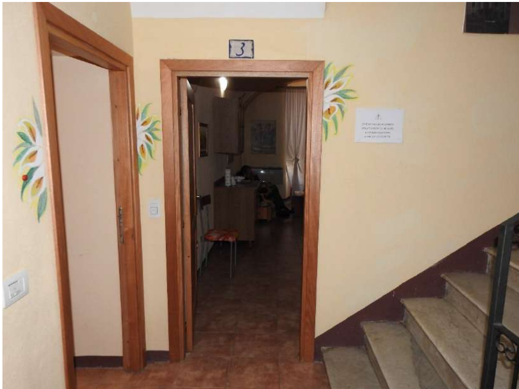
Figura 54 - Ingresso interno 3, piano primo
