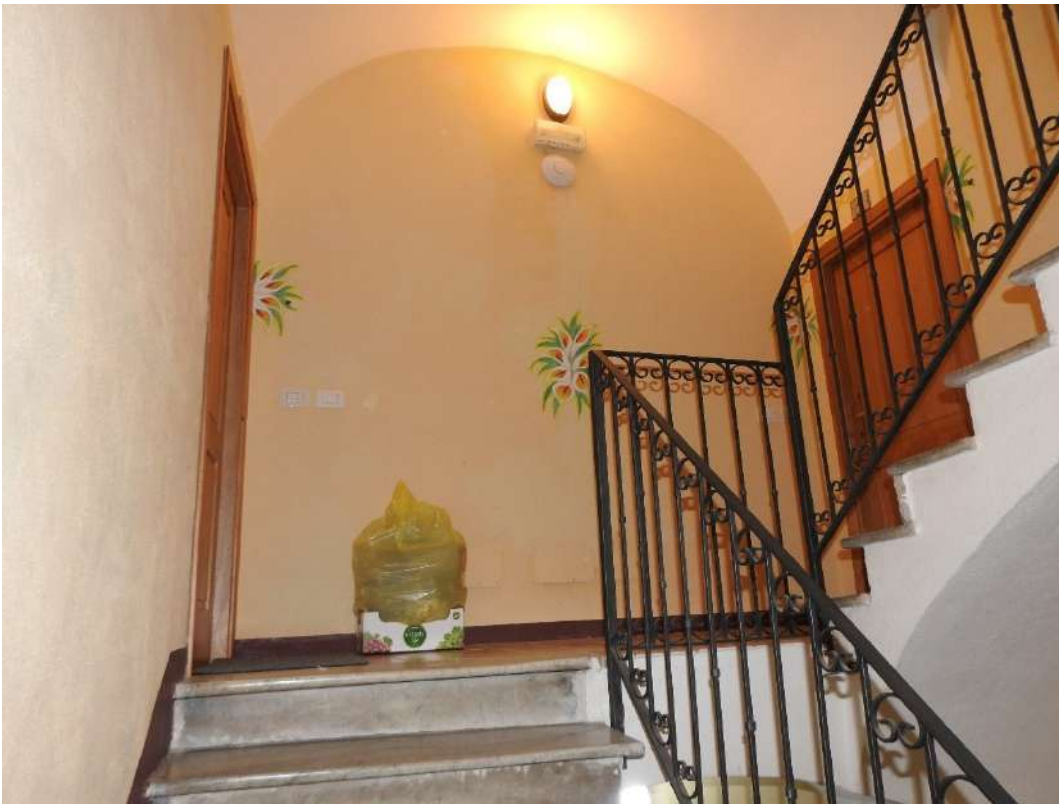
Figura 16 - Vano scala comune (BCNC sub. 11). Visuale del pianerottolo del secondo piano
