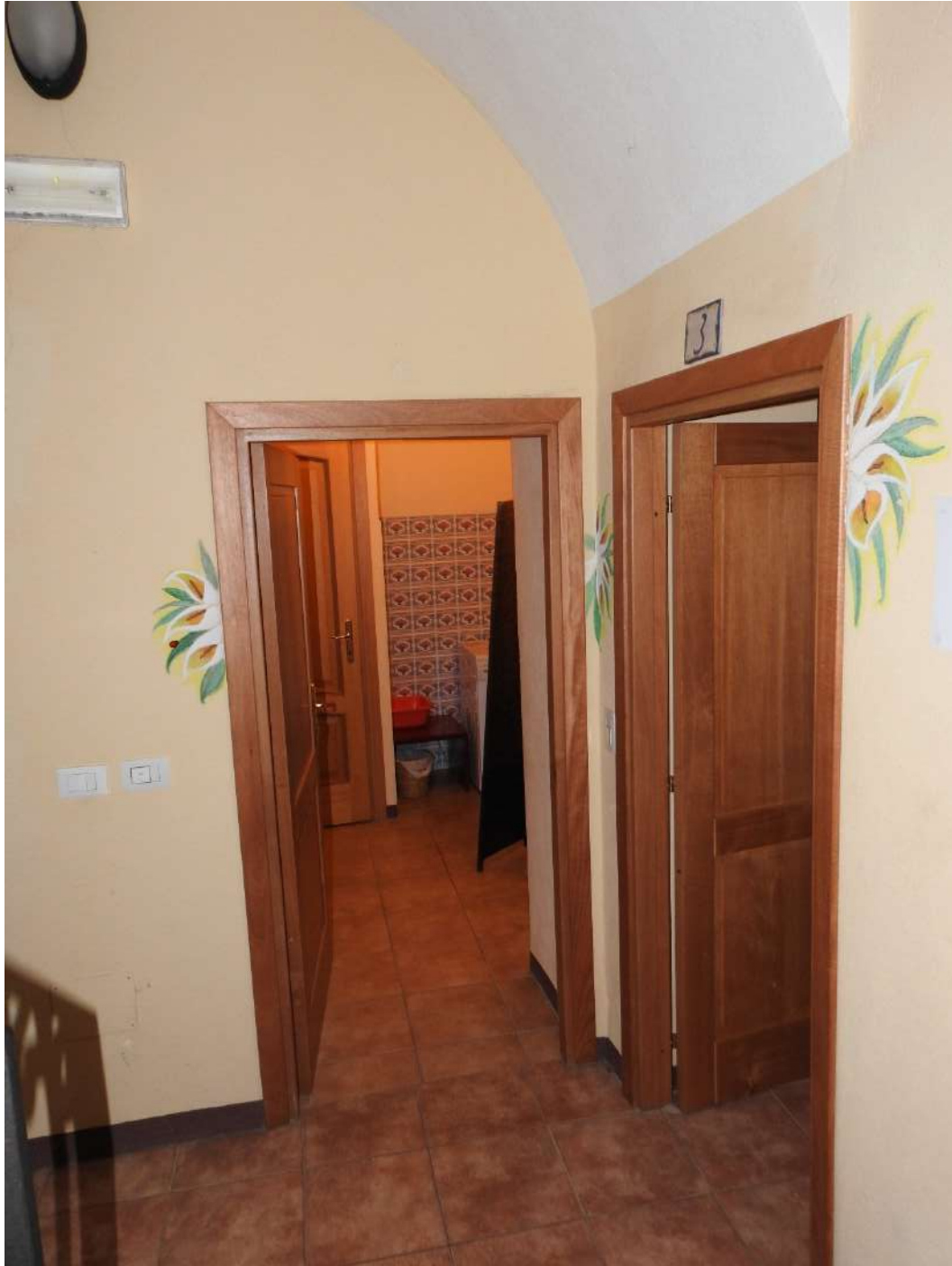
Figura 47 - Ingresso interno 2, piano primo
