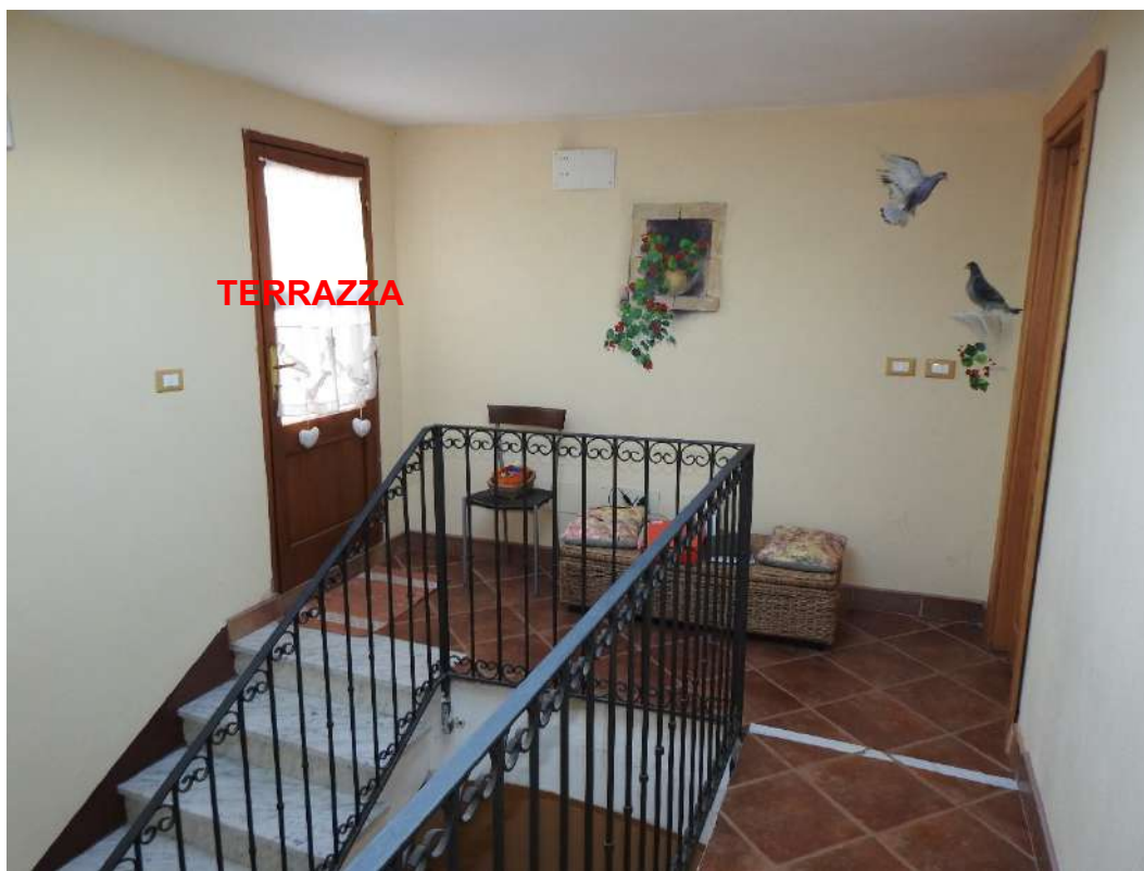
Figura 20 - Vano scala comune (BCNC sub. 11). Visuale del pianerottolo del quarto piano
