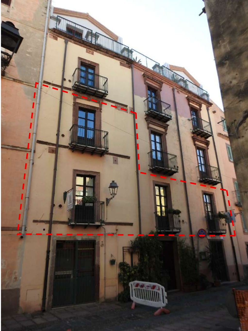
Figura 37 - Lotto 2, visuale esterna dal Corso Vittorio Emanuele II
