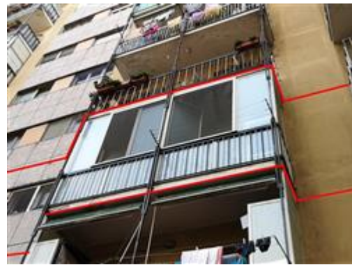
L'unità oggetto di valutazione (affaccio Nord-Est)
