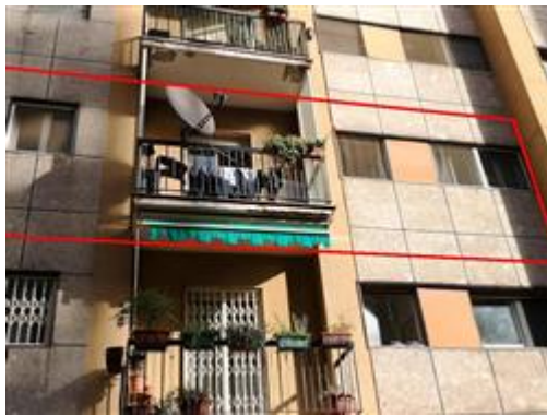
L'unità oggetto di valutazione (affaccio Sud-Ovest)
