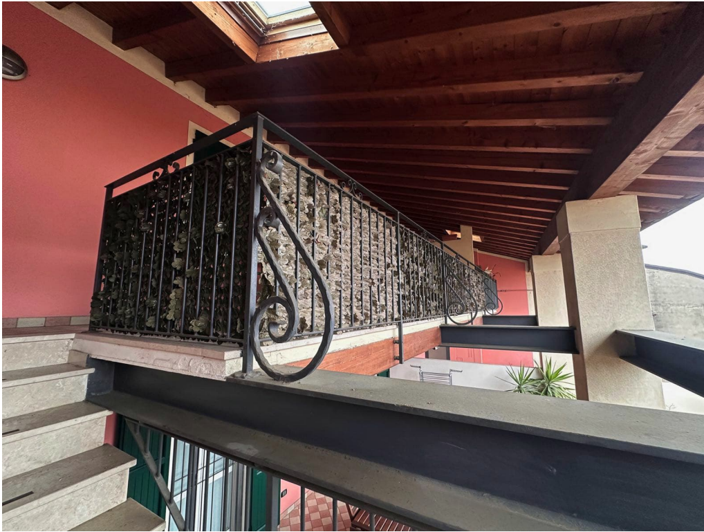
Foto 14 - Vista da scala comune
