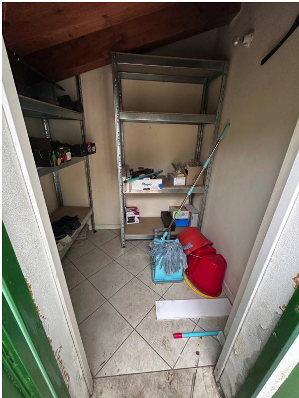
Foto 32- Ripostiglio in terrazza
