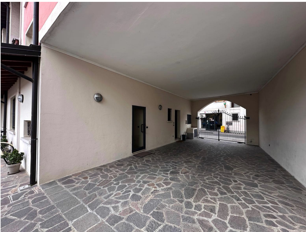
Foto 6 - Passaggio di ingresso
