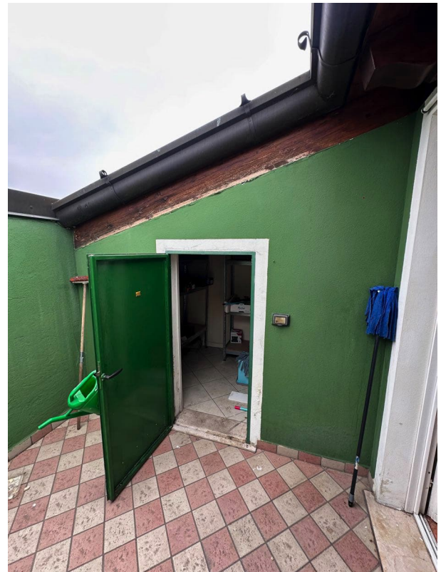
Foto 33- Ripostiglio in terrazza
