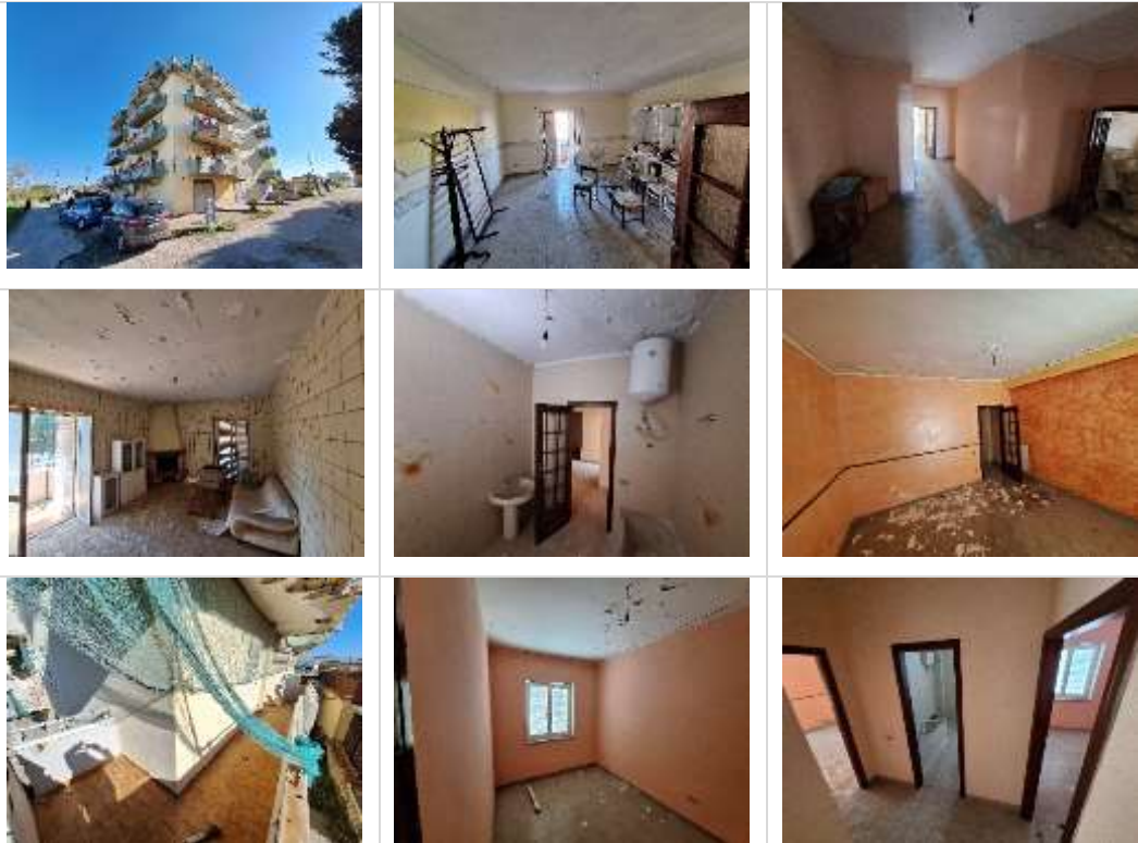
Foto stato dei luoghi
