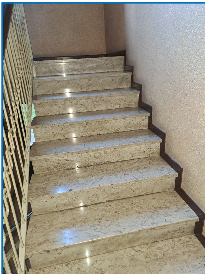
n° 5 Particolare scale condominiali
