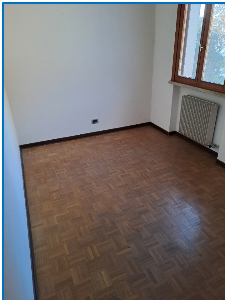
n° 19 – Interno alloggio
