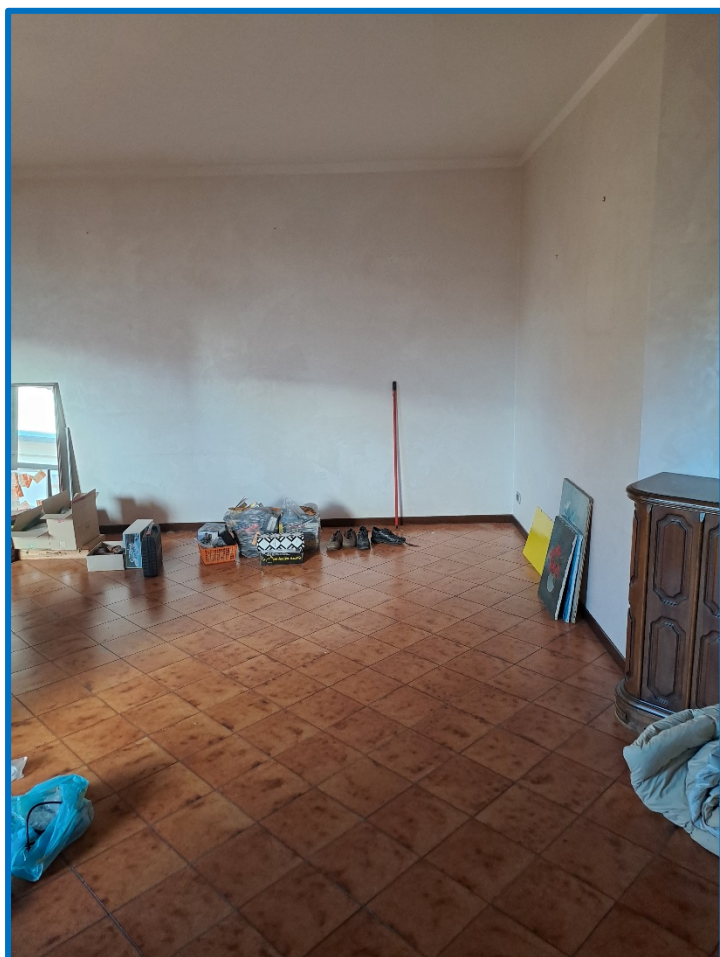
n° 8 – Interno alloggio
