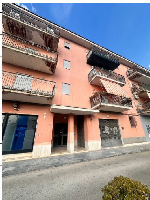
Vista del prospetto edificio
