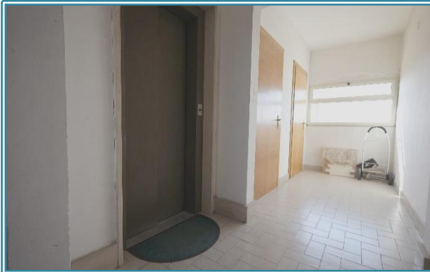
Figura 14 Ascensore con locali condominiali
