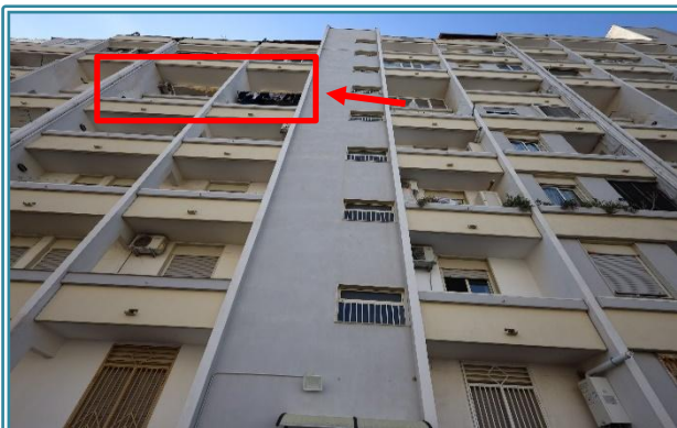
Figura 12 Facciata edificio prospetto est
