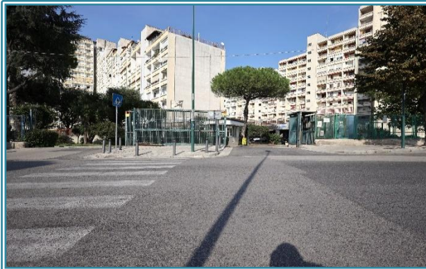
Figura 6 Ingresso al parco da Via Bartolo Longo
