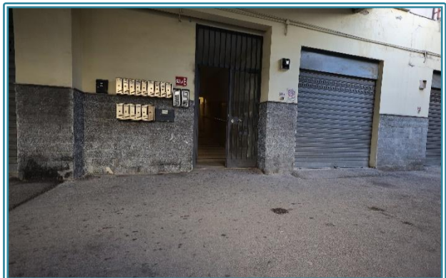
Figura 9 Ingresso "Scala E" dal piano terra (parcheggio)
