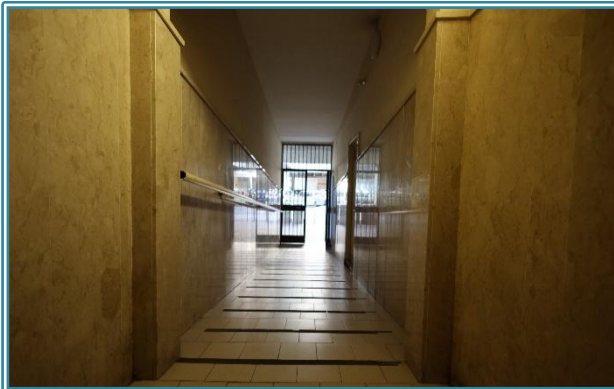
Figura 10 Rampa di accesso che conduce all'ascensore
