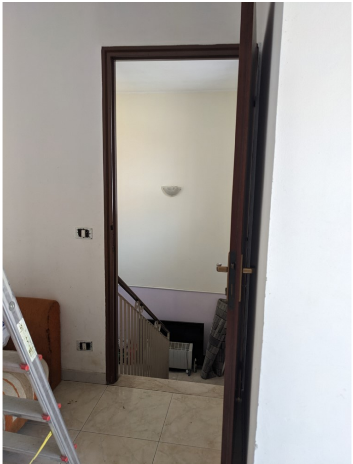
Locale tecnico / lavanderia
