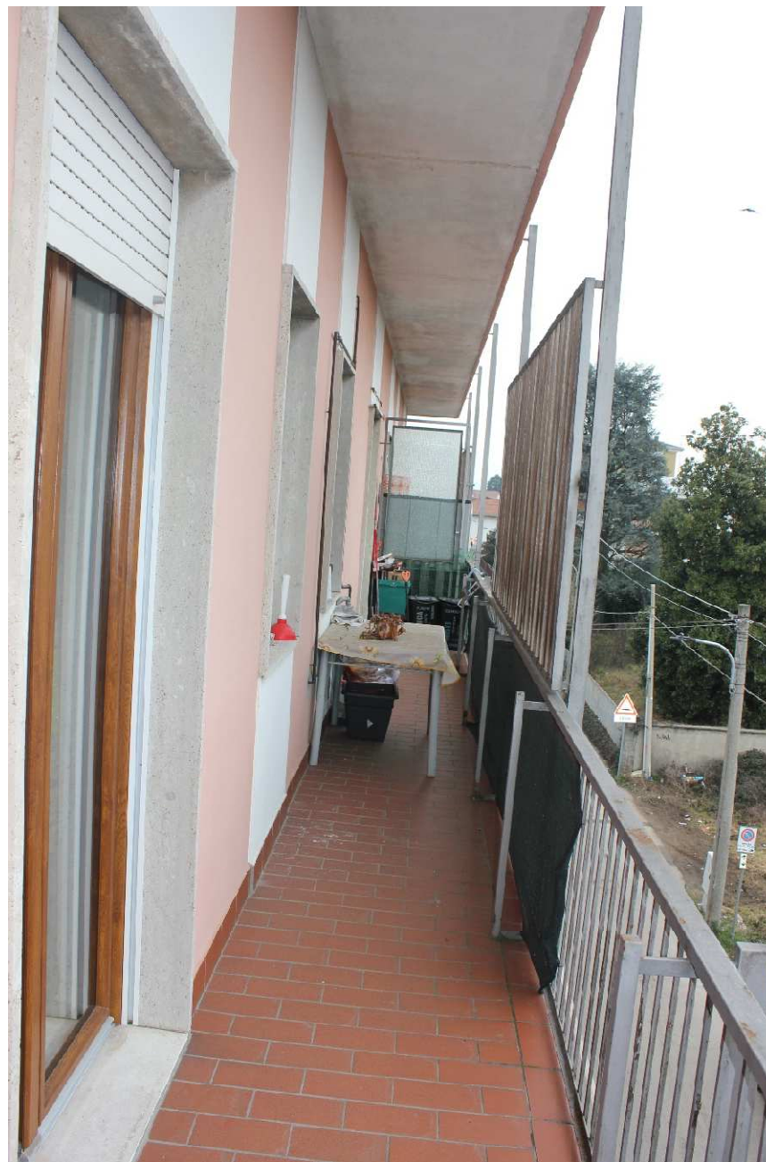
Foto 14 – Balcone con affaccio su via S. Pellico
