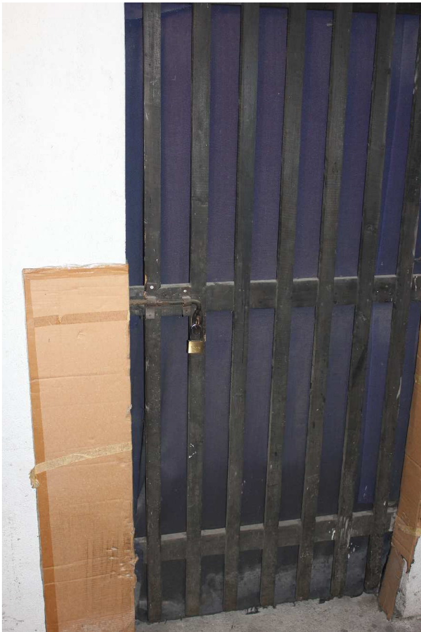
Foto 17 – Porta d'accesso alla cantina
