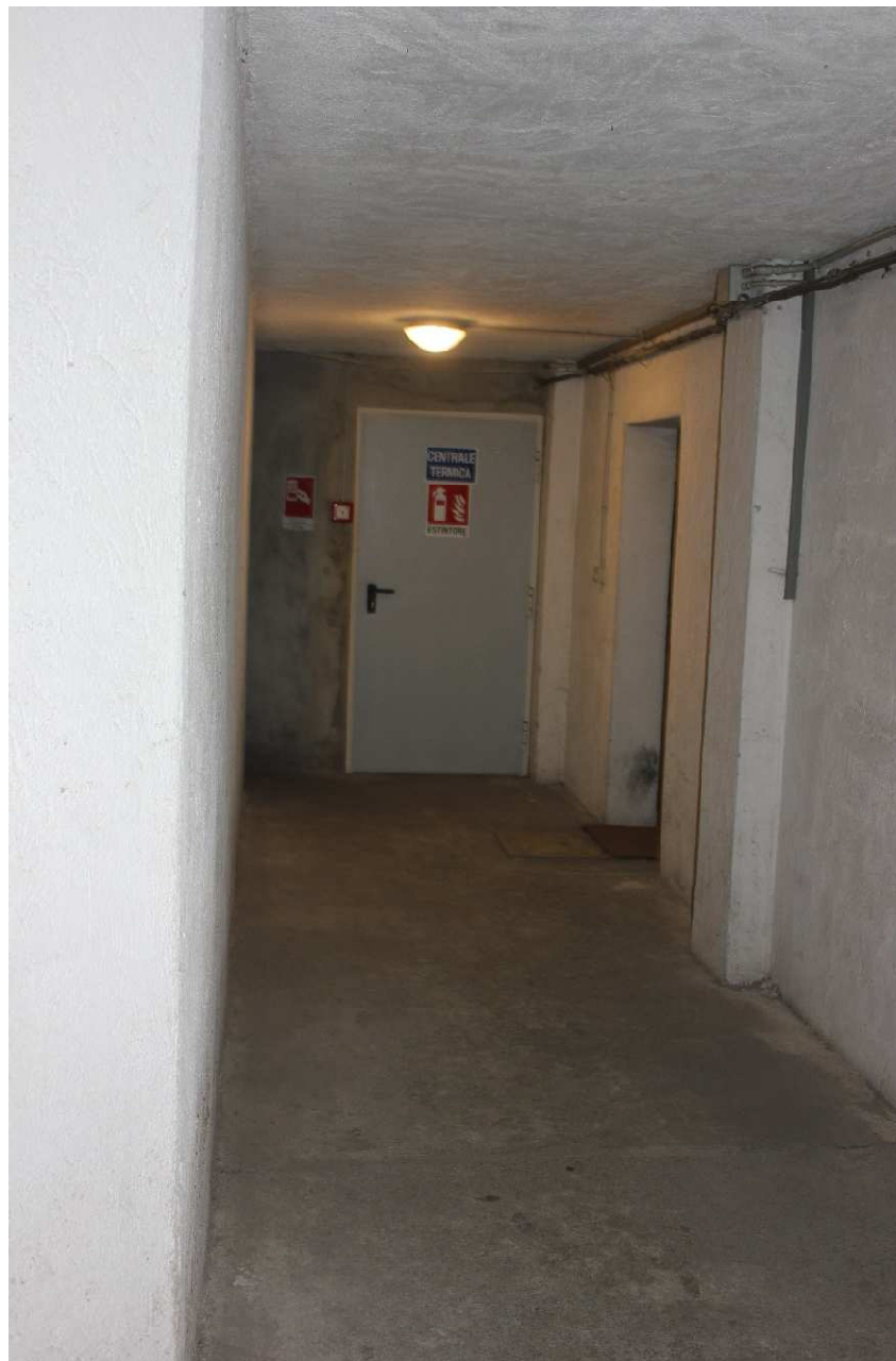
Foto 18 – Corridoi comune al piano seminterrato
