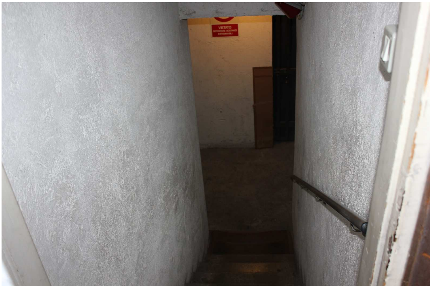
Foto 15 – Vano scale vs piano seminterrato
