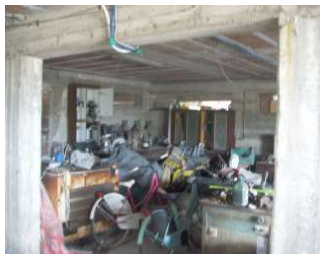
(foto 6: vista deposito)
