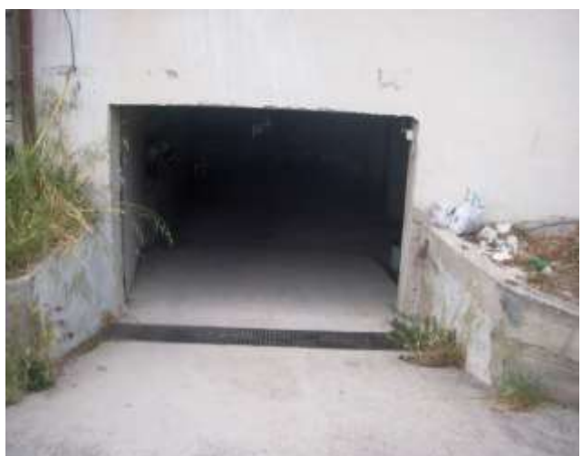
(foto 5: vista rampa)
