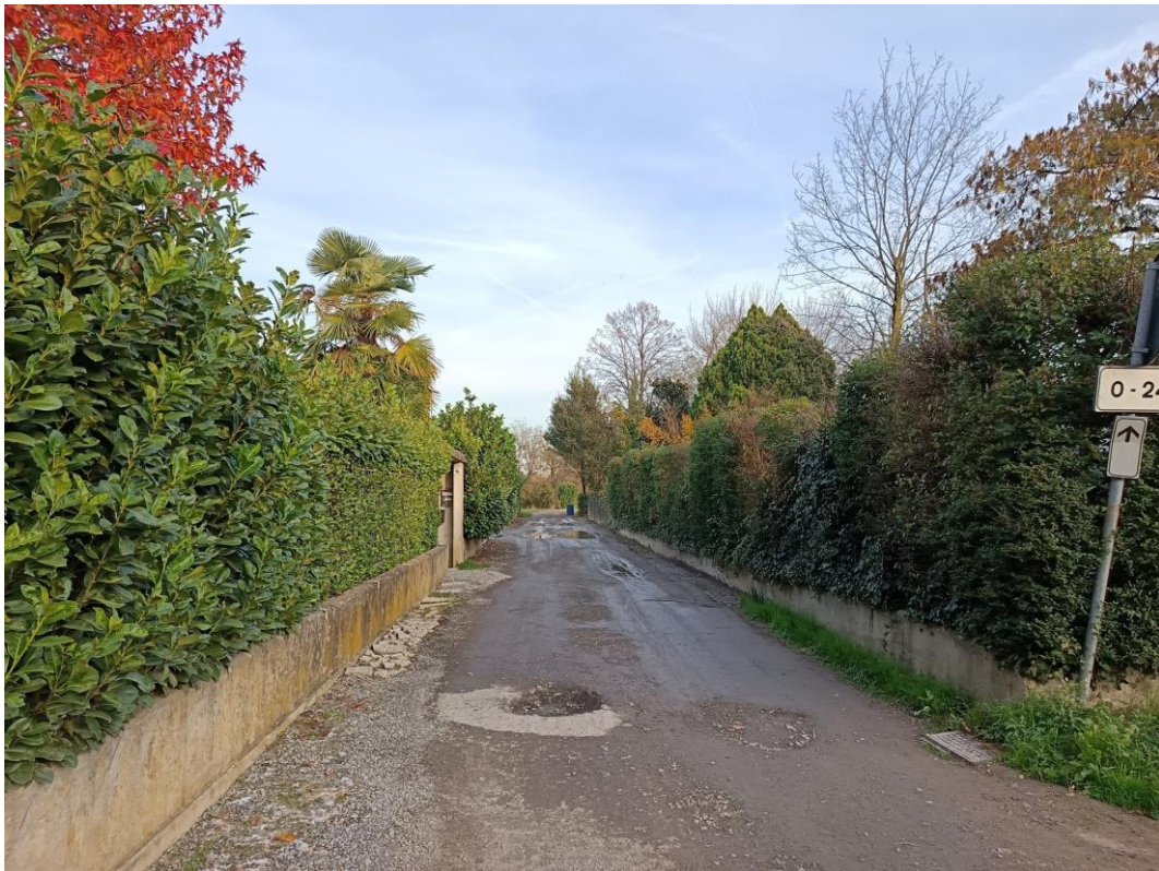
STRADA DI ACCESSO STERRATA DA VIA DON MINZONI
