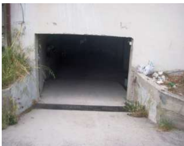
(foto 5: vista rampa)
