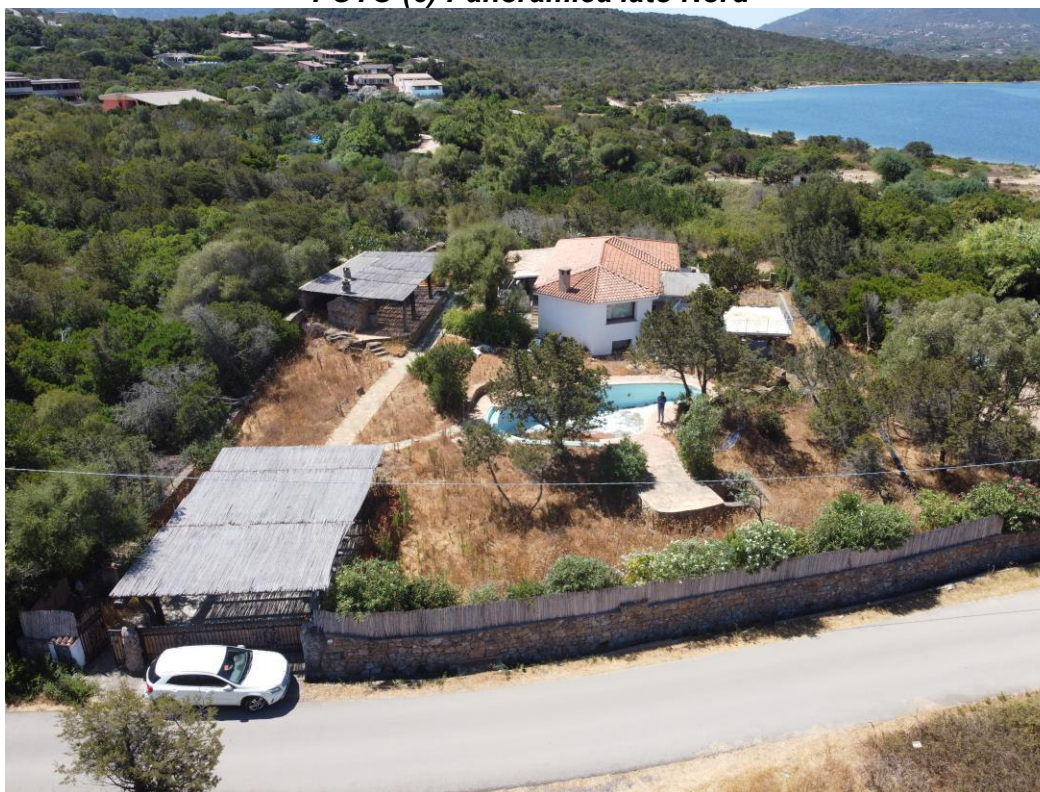
FOTO (6) Panoramica lato Nord
