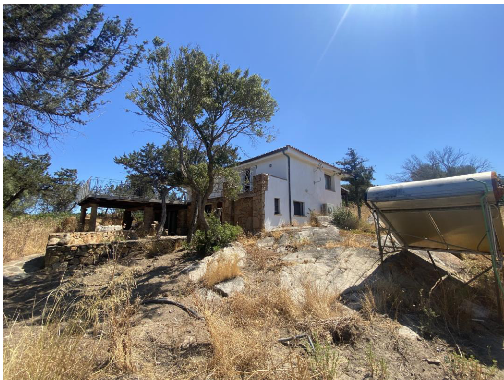
FOTO (14) prospetto Sud-Ovest
