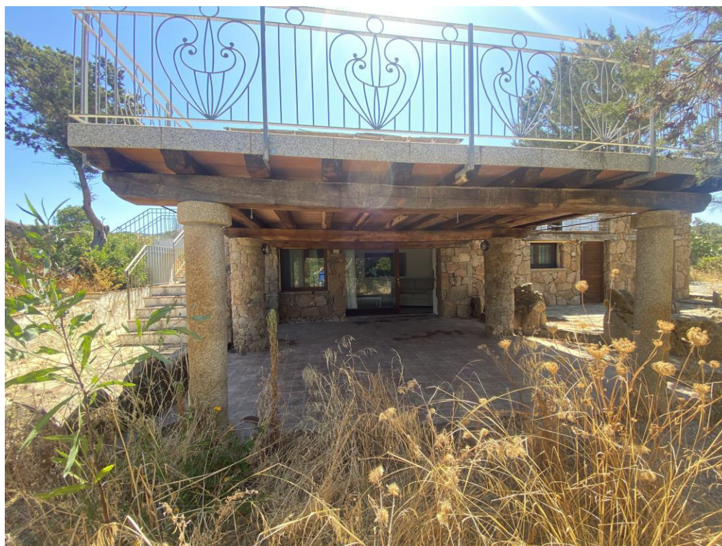
FOTO (12) prospetto Ovest
