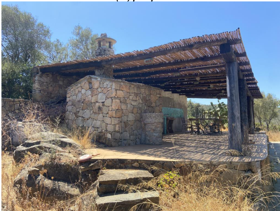
FOTO (21) prospetto Nord
