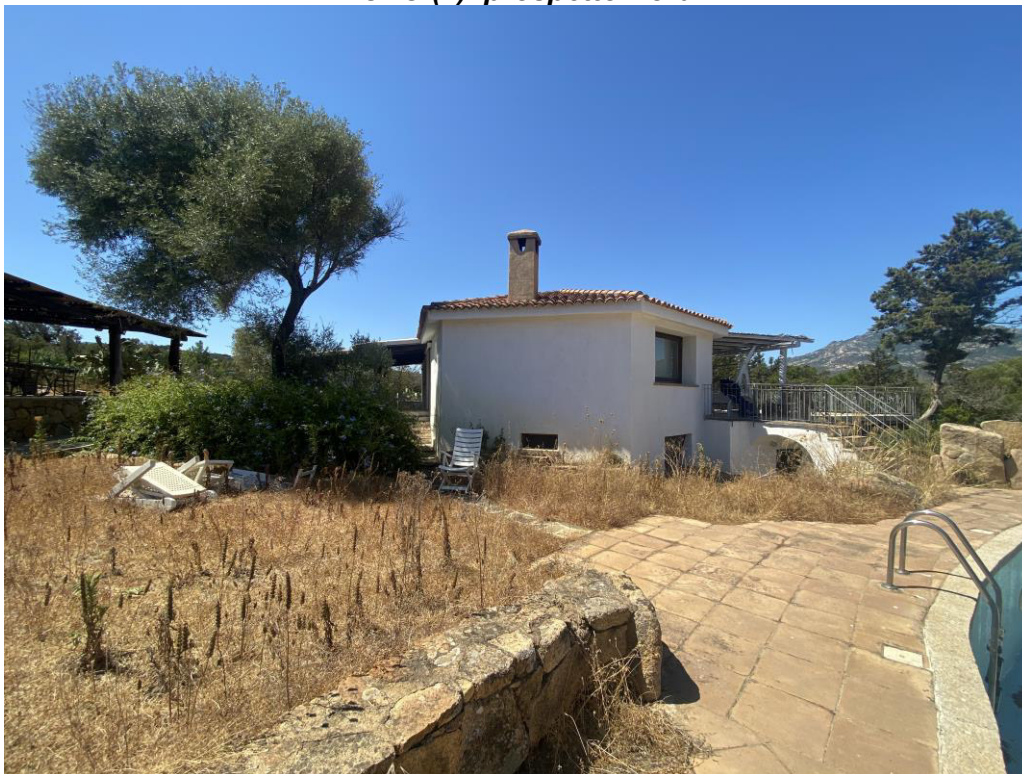
FOTO (7) prospetto Nord
