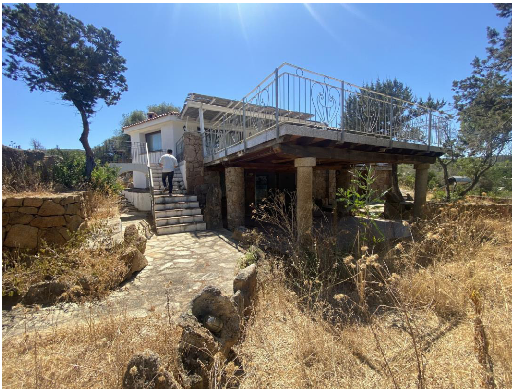
FOTO (11) prospetto Ovest
