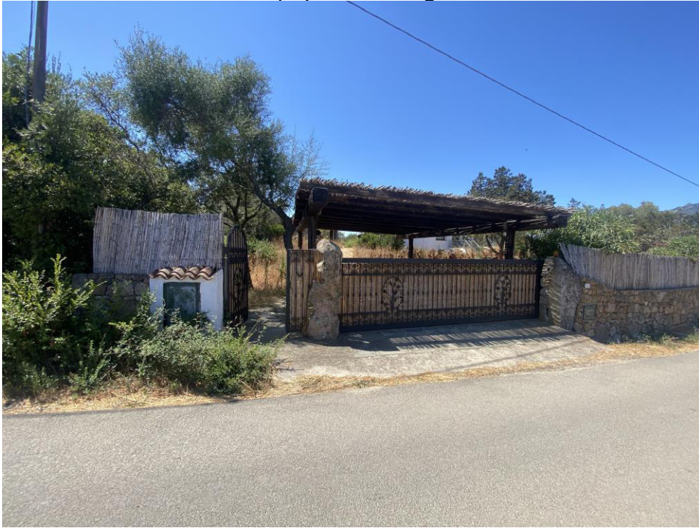
FOTO (23) Cancelli ingresso
