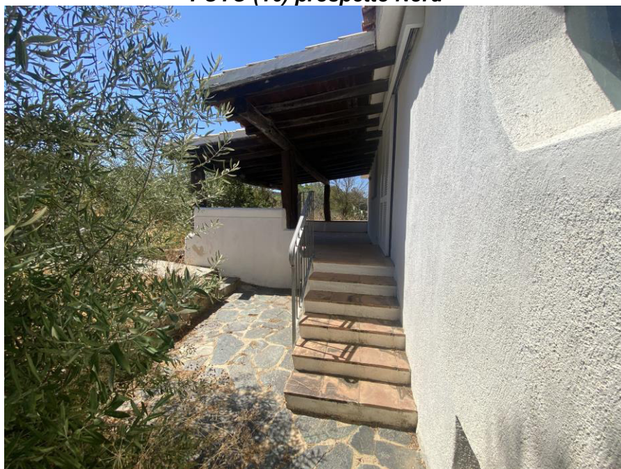
FOTO (16) prospetto Nord
