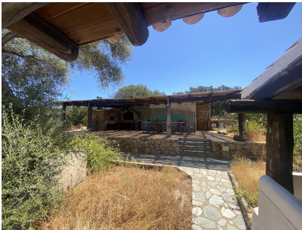
FOTO (17) prospetto Ovest
