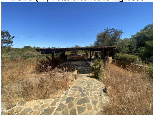
FOTO (22) Tettoia cancello ingresso
