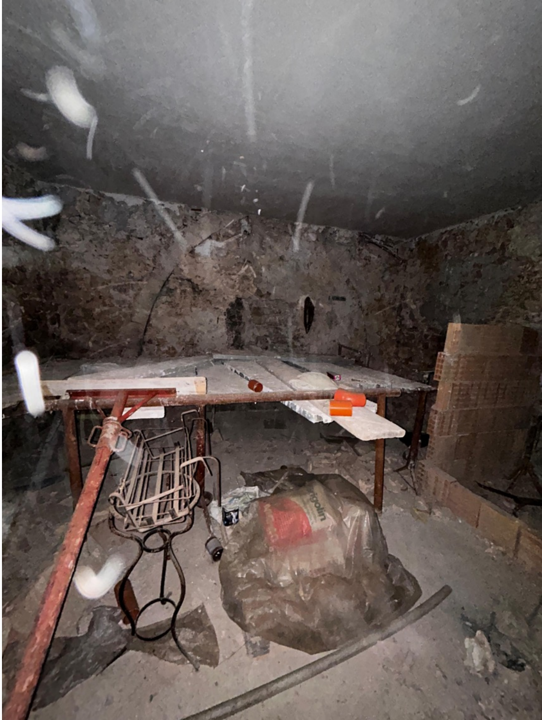
FOTO 12 PRIMO LOCALE AL PIANO SEMINTERRATO
