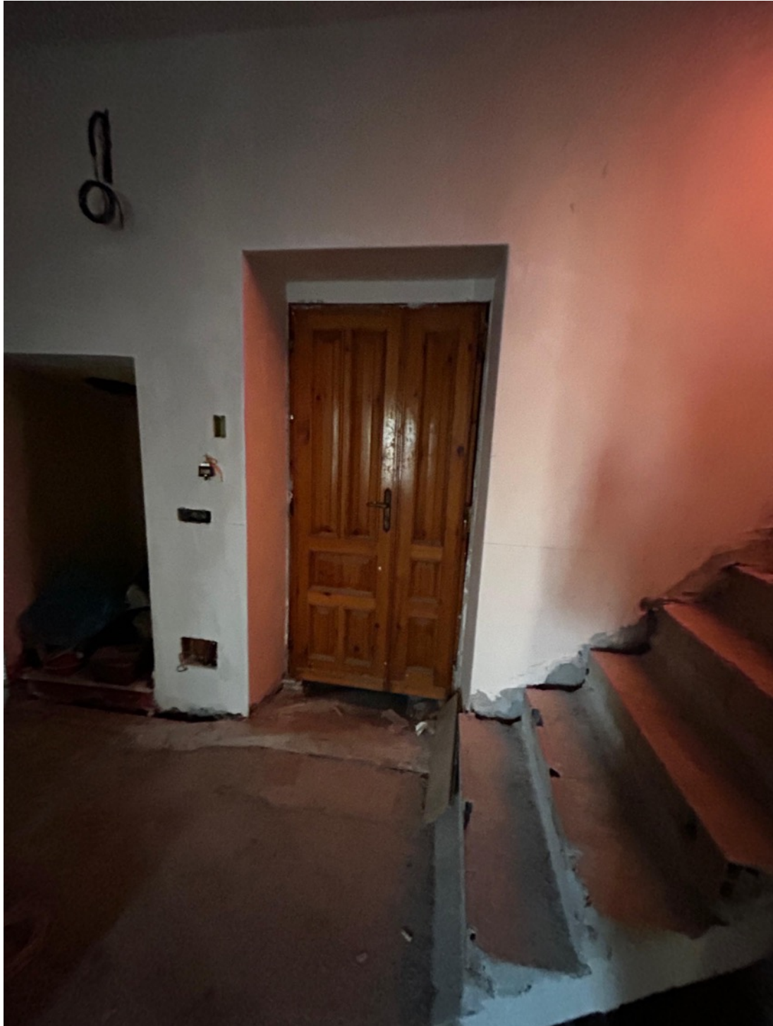
FOTO 3. PIANO TERRA INGRESSO
