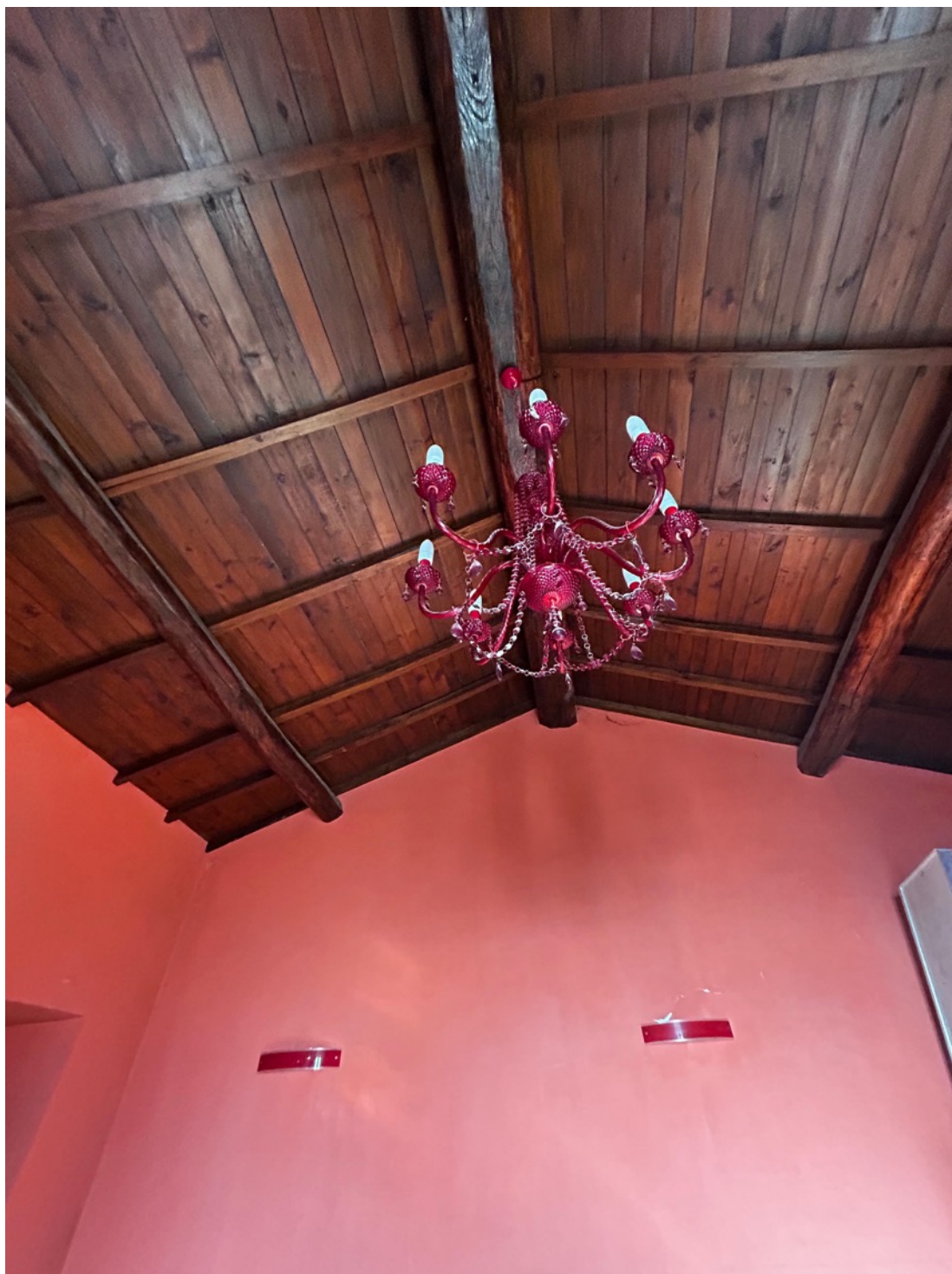
FOTO 9 SOLAIO COPERTURA PIANO PRIMO IN LEGNO
