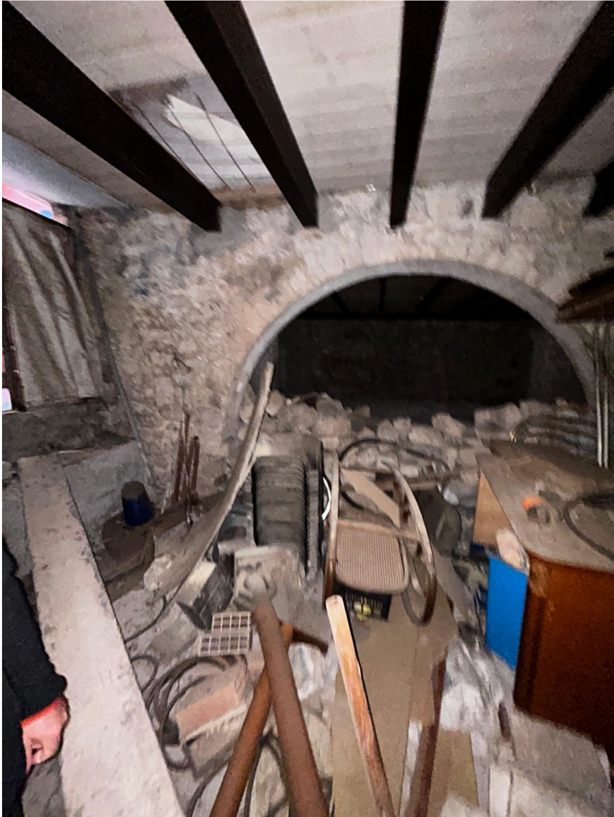
FOTO 13 ARCO DI PASSAGGIO TRA PRIMO E SECONDO LOCALE PIANO SEMINTERRATO (NON ACCESSIBILE)
