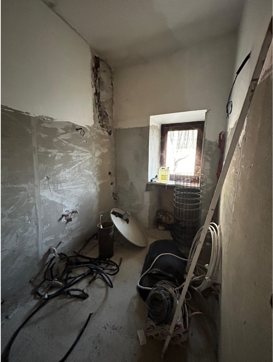
FOTO 4. BAGNO IN ALLESTIMENTO PIANO TERRA
