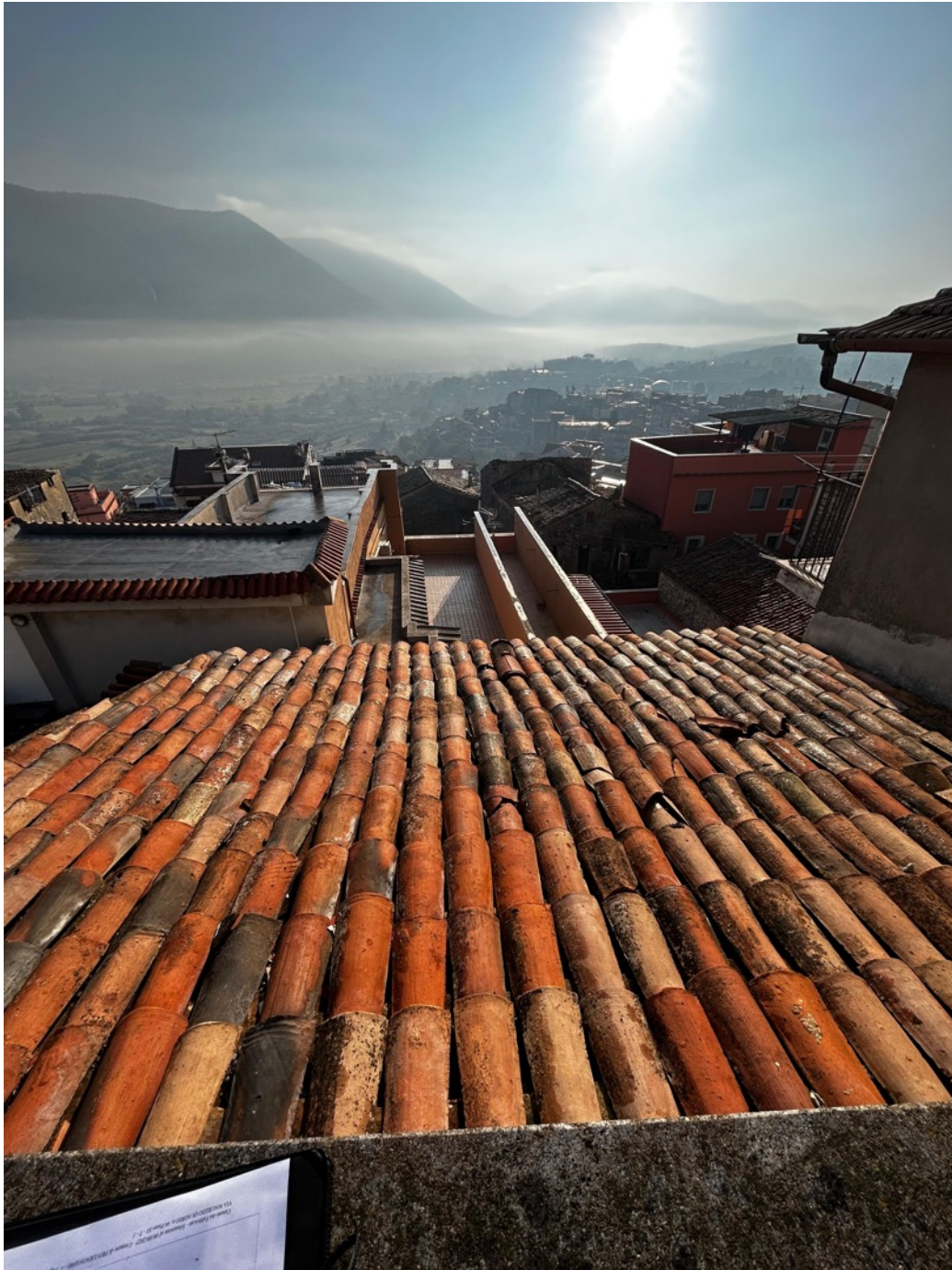
FOTO 10 COSTRUZIONE IN CORRISPONDENZA DEL GIARDINO INDICATO NELLA PLANIMETRIA CATATALE
