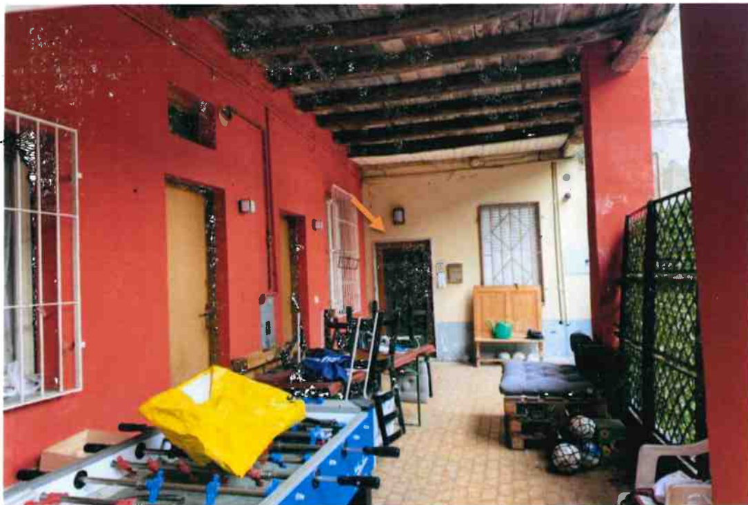
FOTO 2: TREZZO D'ADDA, via Torre 36, ingresso da portico comune
