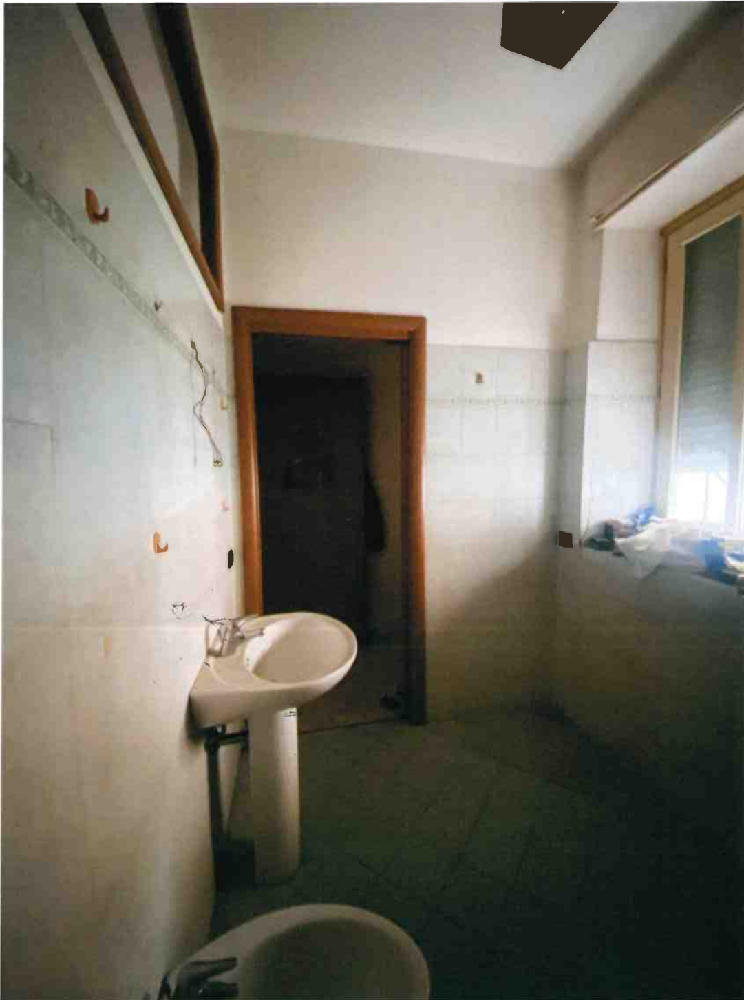
FOTO 7: TREZZO D'ADDA, via Torre 36, bagno
