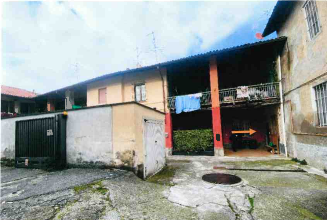
FOTO 1: TREZZO D'ADDA, via Torre 36, ingresso da portico comune
